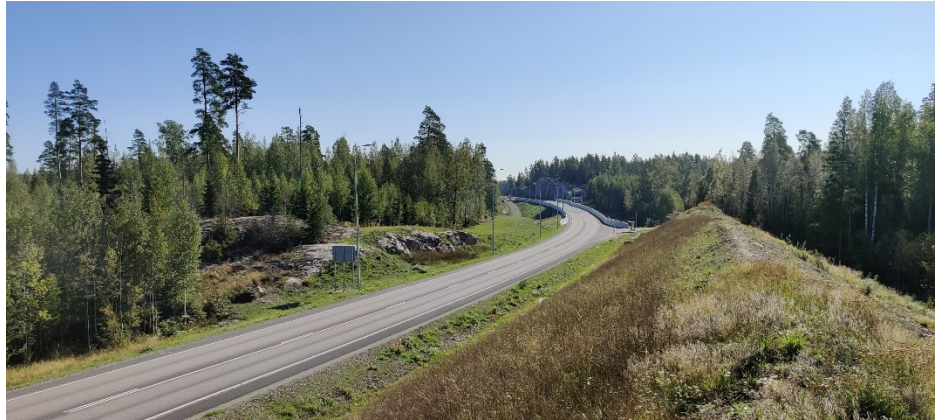
Kuva 1. Luiskien täytöt ja istutustyöt ovat valmistuneet kehätiellä Kuva 1.9.2021
