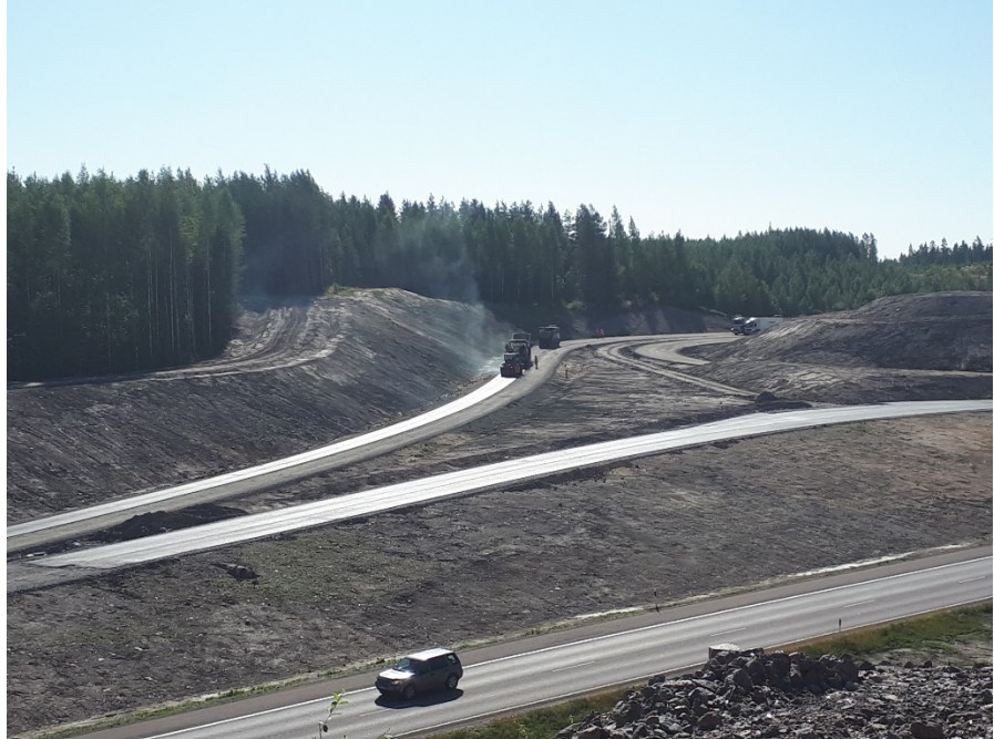
Kuva 2. Lamminsuon eritasoliittymän päällystystyöt käynnissä 20.8.2020
