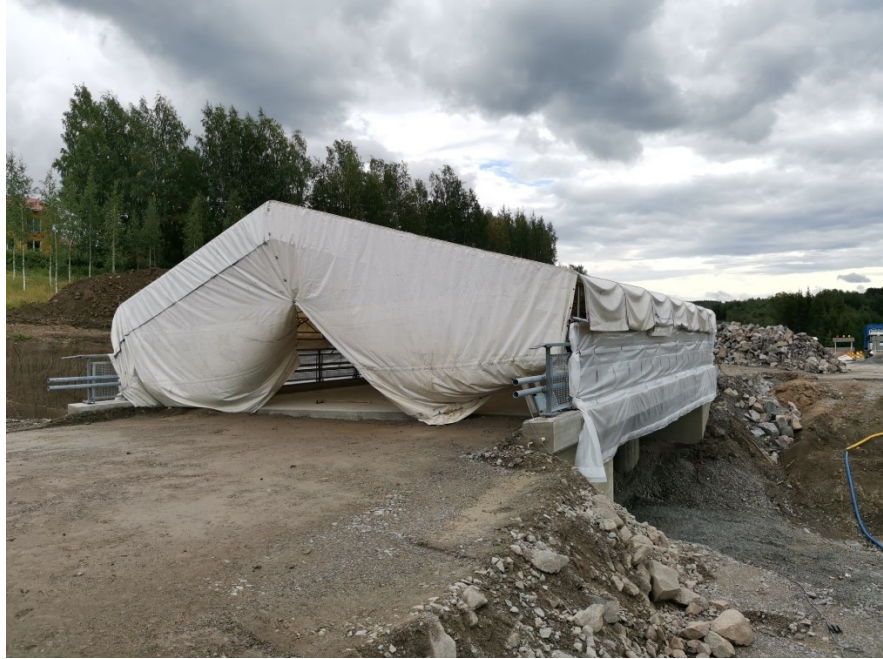
Kuva 1. S104 Numlahden alikulkukäytävän sääsuoja ja kaiteet 25.8.2020
