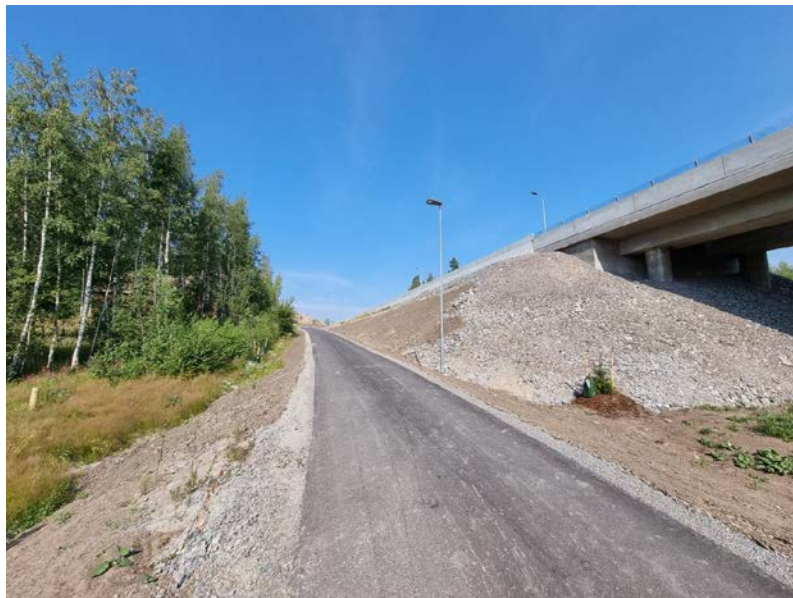
Kuva 2. S3 etelä/länsipuolen luiska viimeistely ja kasvualusta lisätty. Kuva 15.7.2021
