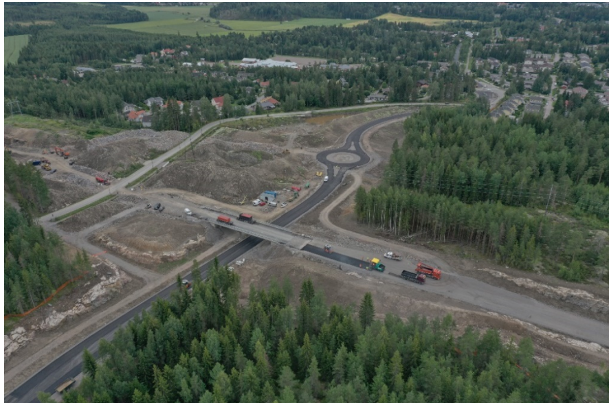
Kuva 3. Kirkkotien eritasoliittymä 4.8.2020 ja Kirkkotien uusi linjaus
