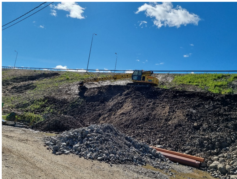
Kuva 2. Luiskan levitys ja muotoilu käynnissä n. pl. 7000, kuva 15.6.2021
