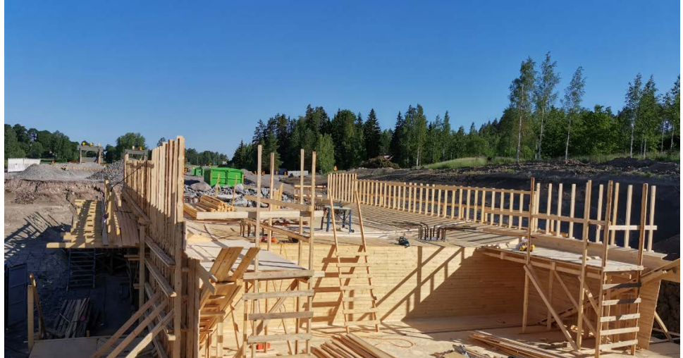
Kuva 1. S104 muottityöt pääosin valmiit. 25.6.2020
