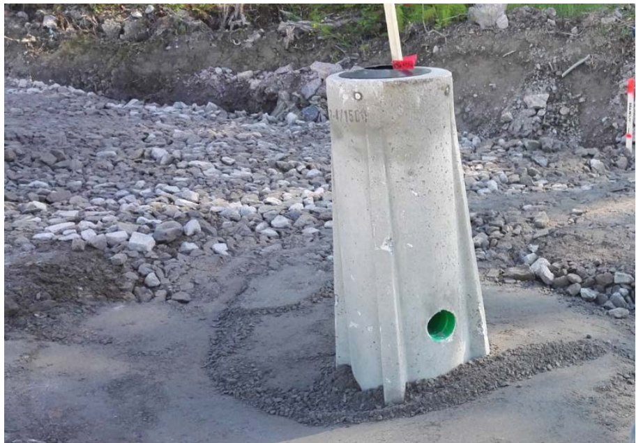
Kuva 4. Kirkkotien ja Havumäentien risteuksen valaistuksen asennus 10.6.2020
