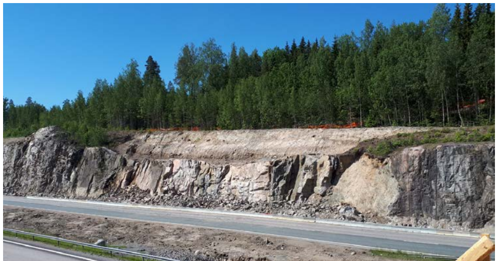
Kuva 2. Vt 3 rampin E5R3 kallioseinämä yö louhinnan jälkeen 17.6.2020
