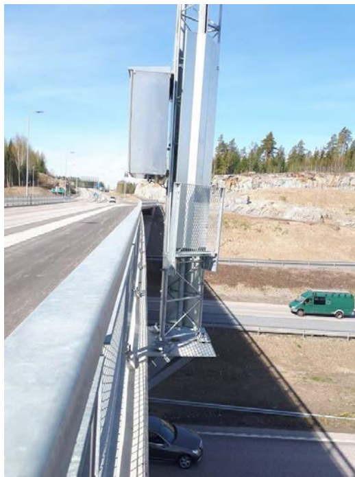
Kuva 4. Kameramastojen asennus käynnissä, kuva 11.5.2021
