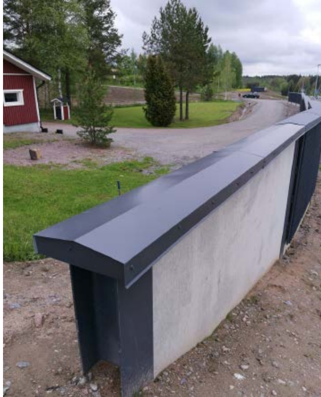
Kuva 1. Meluseinän Me1 hattupelti asennettu, kuva 27.5.2021
