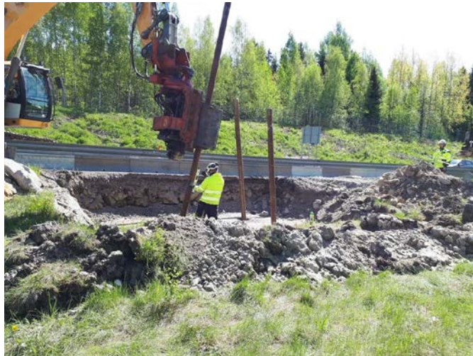
Kuva 3. Tiedotusopasteportaalin T1 perustusten paalutus käynnissä, kuva 24.5.2021.
