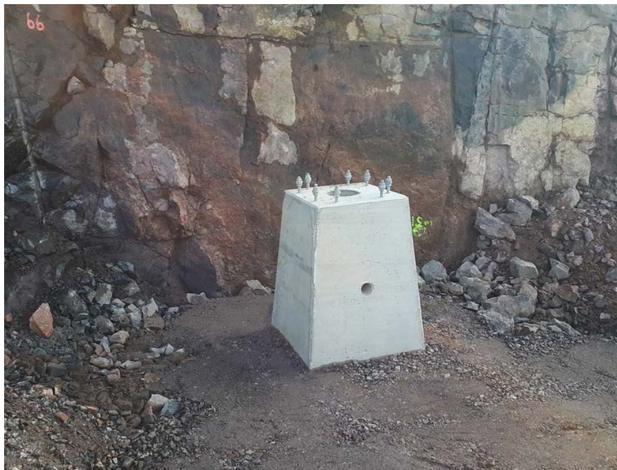
Kuva 4. Kirkkotien läheisyydessä liikenneportaalin jalusta asennettu 19.5.2020
