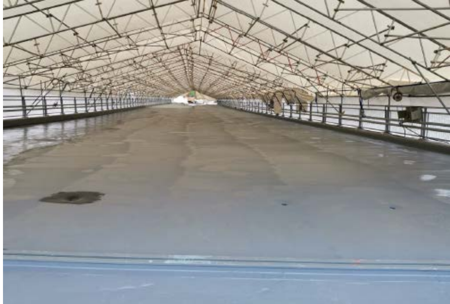
Kuva 1. S5 vedeneristystyöt työt käynnissä 28.5.2020
