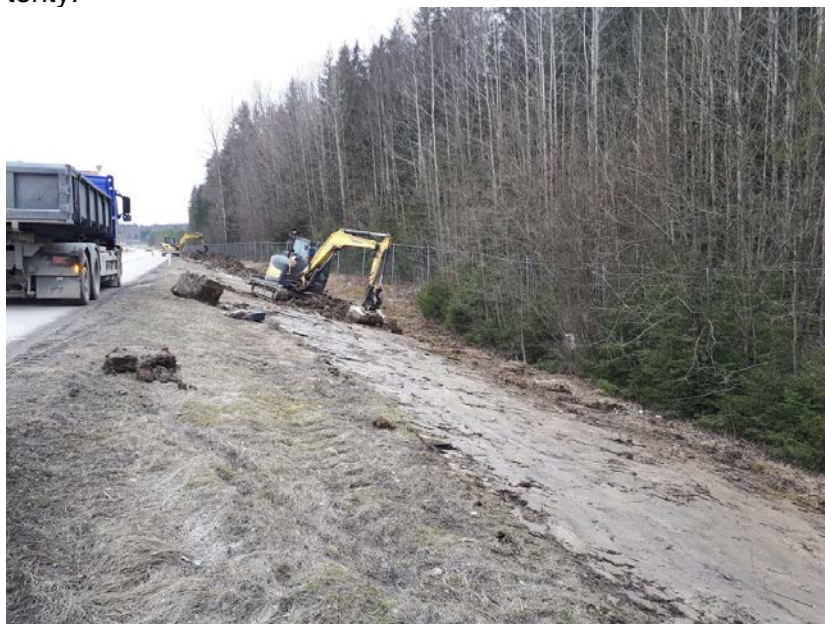
Kuva 3. Kaivanto on peitetty ja ojan muotoilu käynnissä, kuva 23.4.2021
