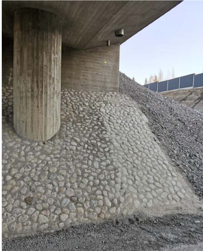
Kuva 1. S104 pintavesikaivon alapuoliset kiviverhoukset saumattu. kuva 21.4.2020
