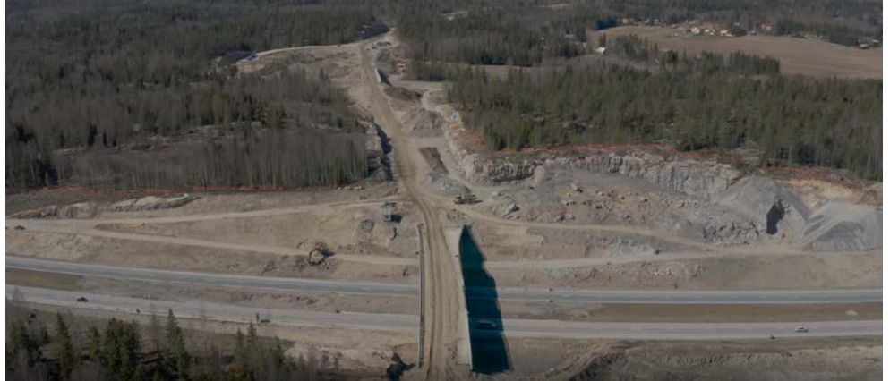
Kuva 1. Silta S5 ja Vt3:lle liittyvät rampit, ilmakuvaus 22.4.2020
