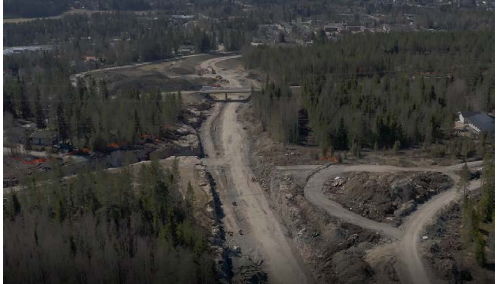
Kuva 3. Uutta Kirkkotien pohjaa etelään päin, ilmakuvaus 22.4.2020
