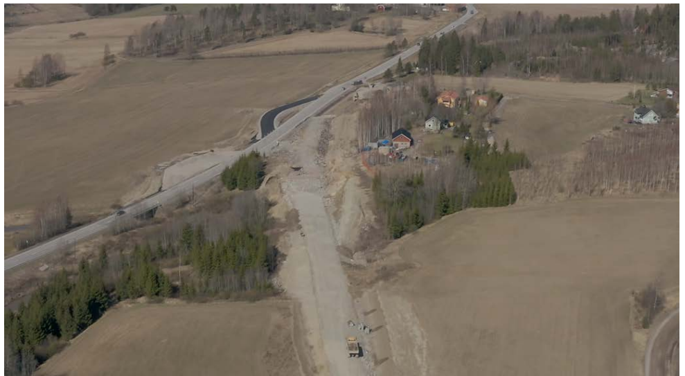
Kuva 4. Kiertotie sillan S104 rakentamista varten, ilmakuvaus 22.4.2020
