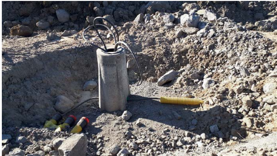
Kuva 3. Valaistusjalustoja ja kaapelointeja tehty.
