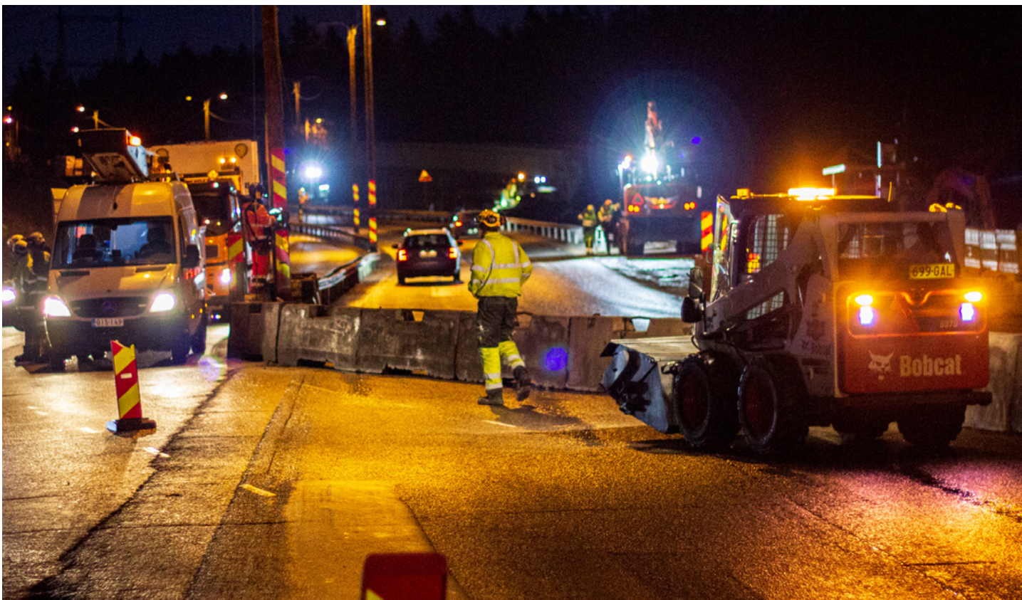
Työnaikaisen kiertoliittymän käyttöönotto
