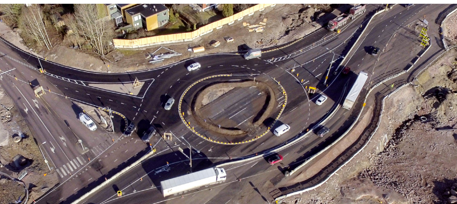
Kehä I:n ja Turvesuontien työnaikainen kiertoliittymä
