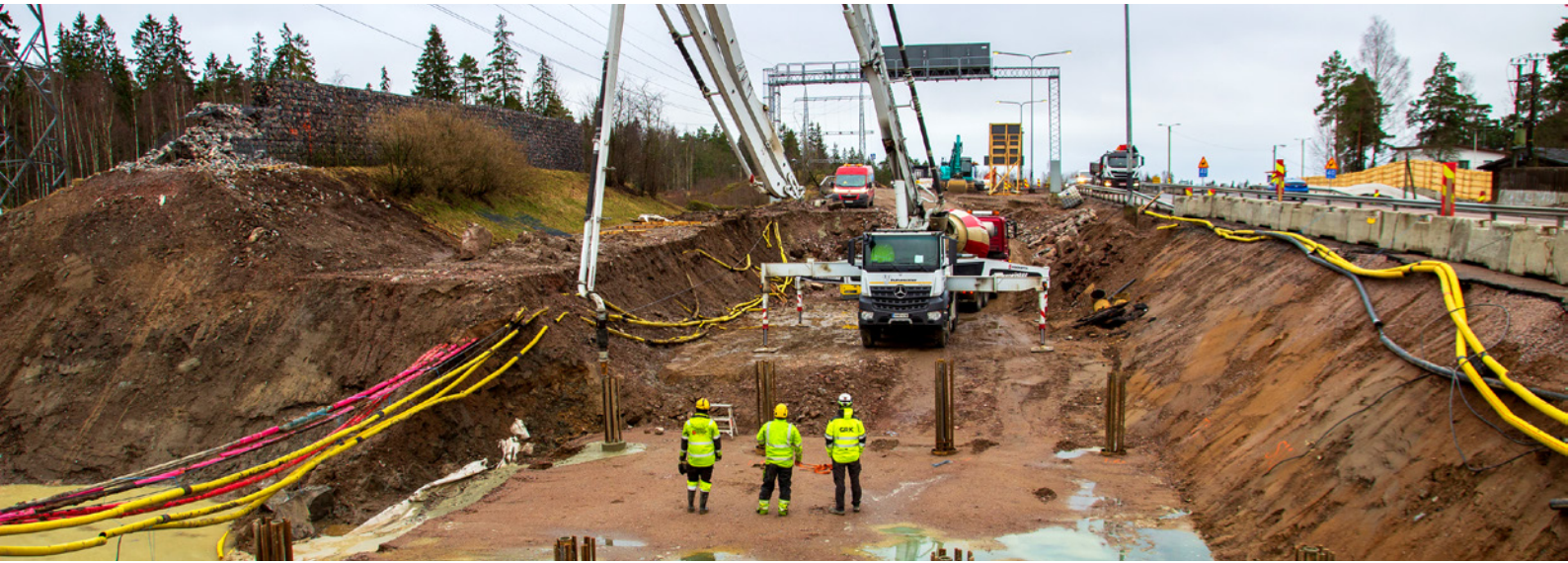
Ruukinrannan alikulkukäytävän sillan porapaalut
