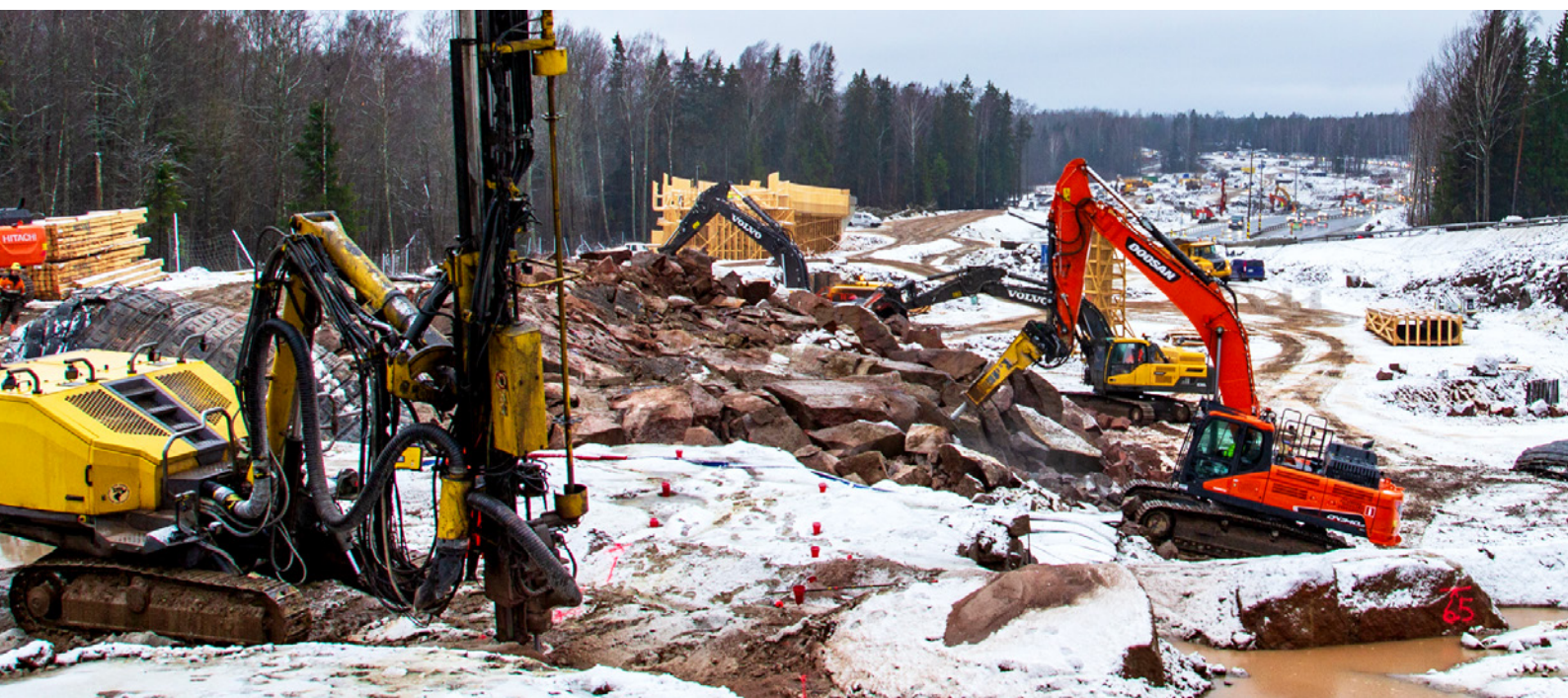
Raide-Jokerin Räisälänsillan rakentaminen
