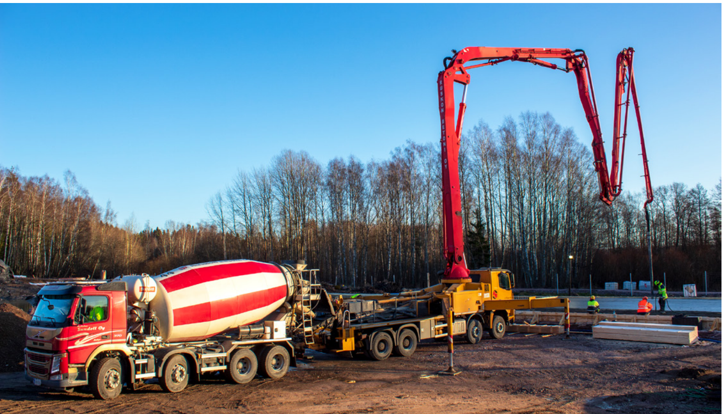
Paalulaatan valu Sakkolantiellä tammikuussa 2020.
