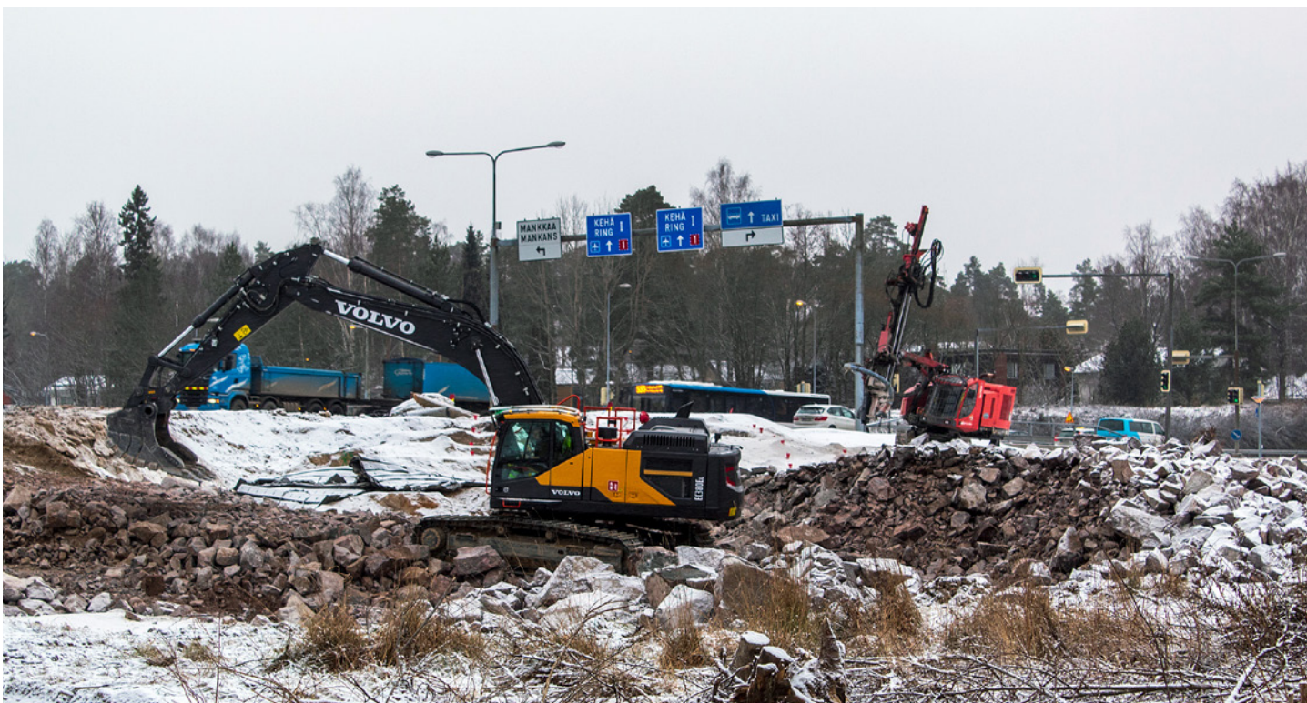
Maanrakennustöitä Sakkolantiellä marraskuussa 2019.
