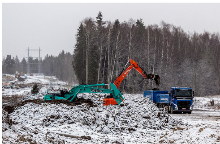
Maanrakennukseen liittyviä töitä Sakkolantiella marraskuussa 2019.
