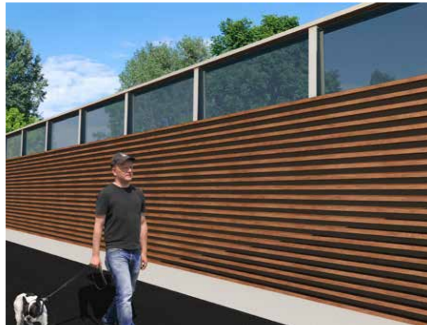
Korkeaa melustetta voidaan keventää läpinäkyvällä yläosalla.
