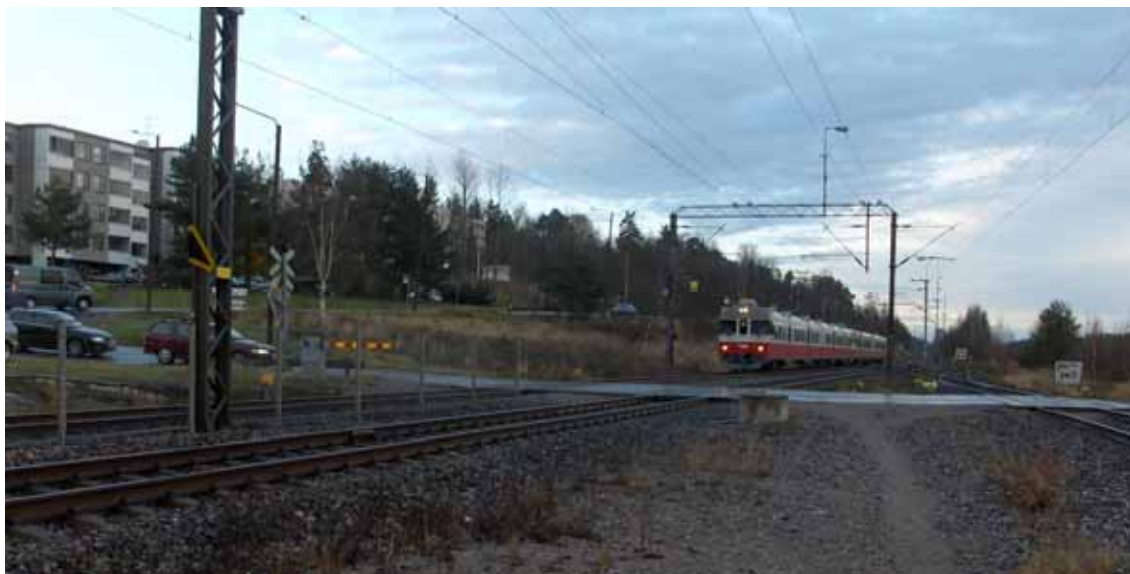
Kuva 2. Rantarata Kauklahten välilaiturilta itään.
