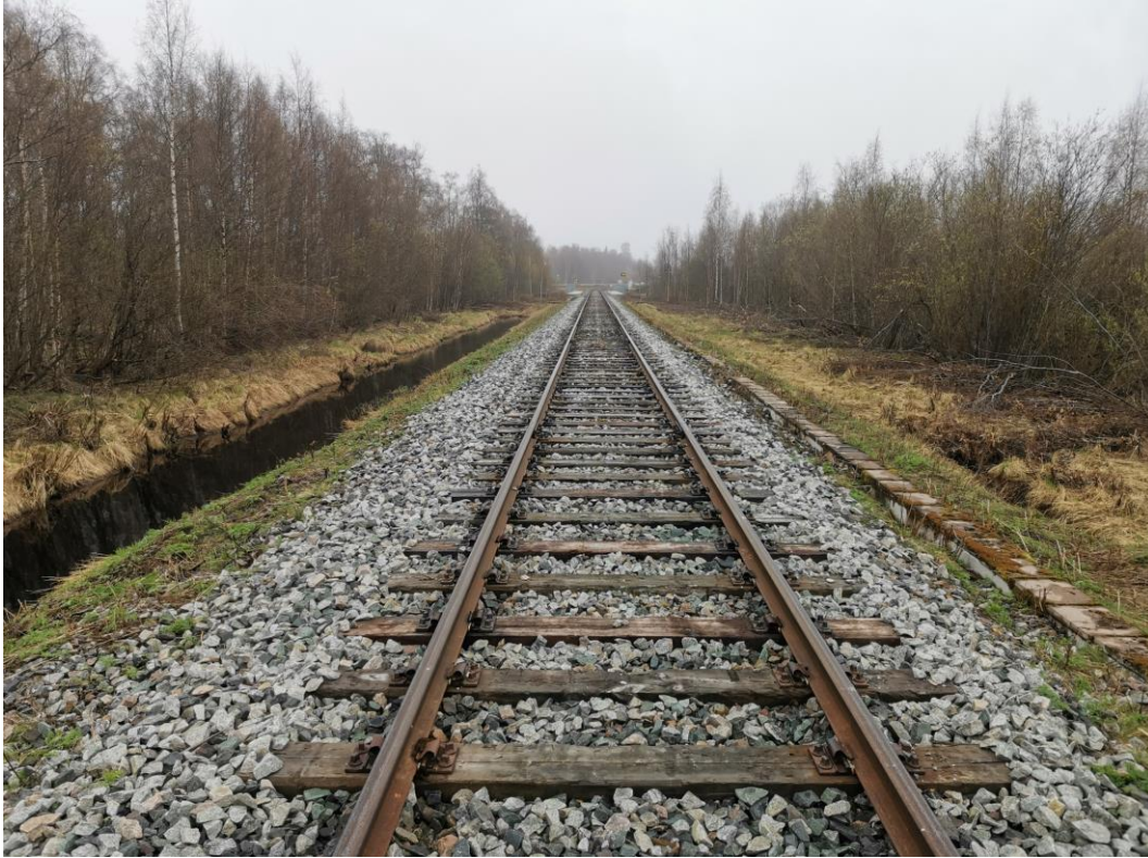
Kuva 23. Etelän suuntaan uusittavalta raiteelta R741.
