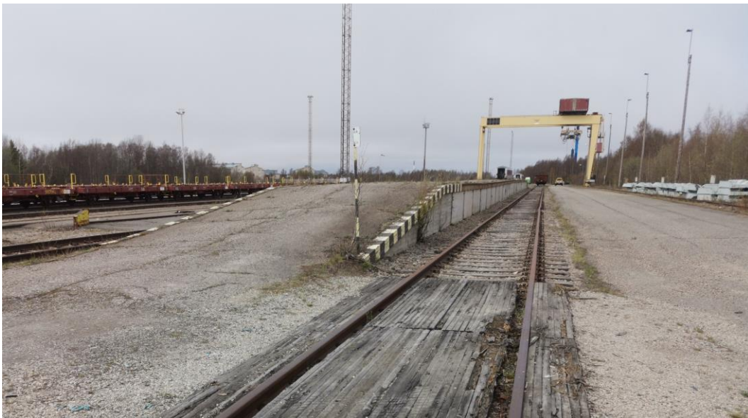
Kuva 4. Nykyinen siirtokuormauslaituri sekä nosturi Tornion ratapihalla. Kuvaussuunta pohjoiseen.
