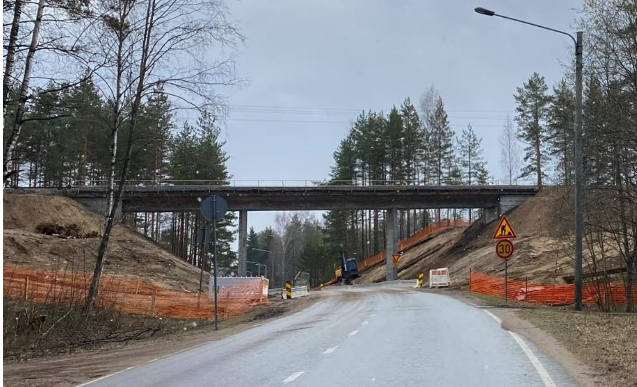
Muukon alikulkusilta Utrasaarentie
