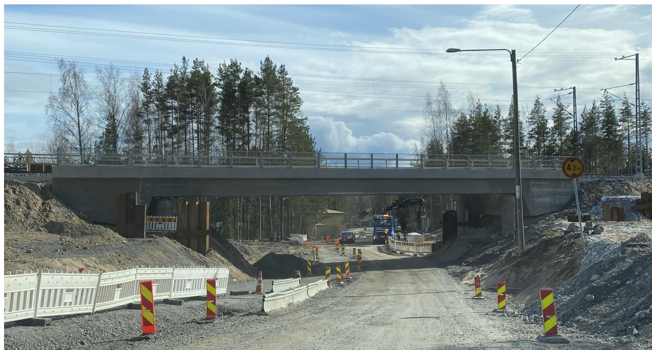
Rauhan alikulkusilta Tiuruniementie
