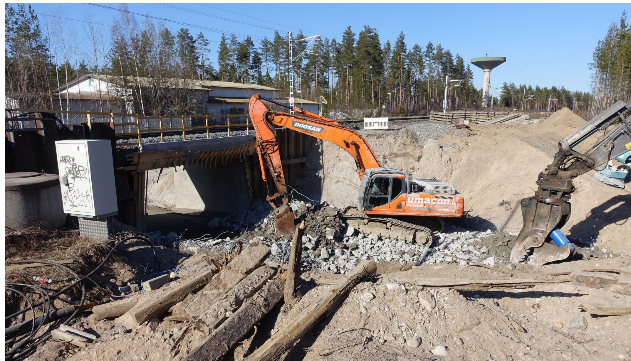
Rauhan aseman alikulkusilta Varastotie
