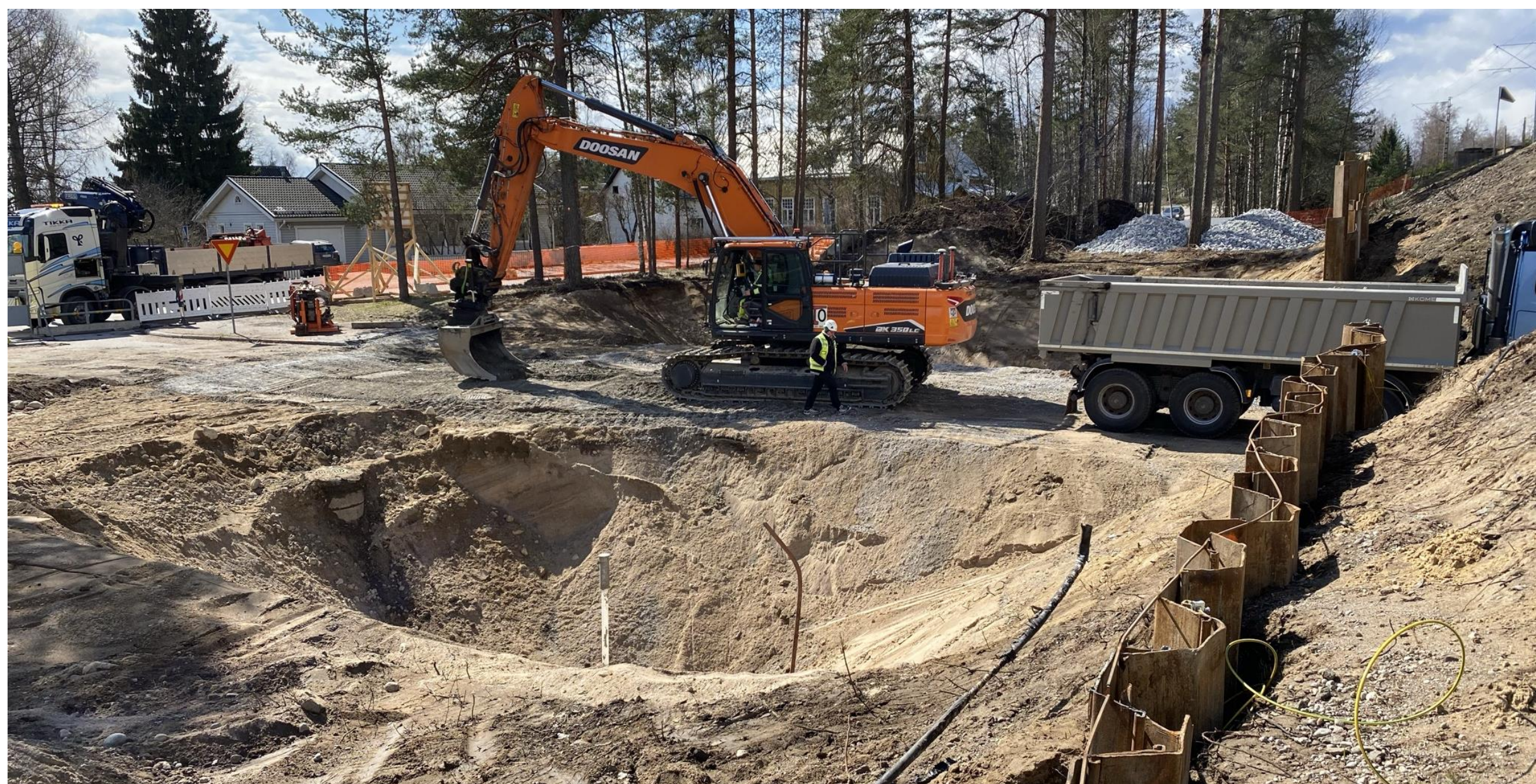
Hakalin alikulkusilta Hakalintie
