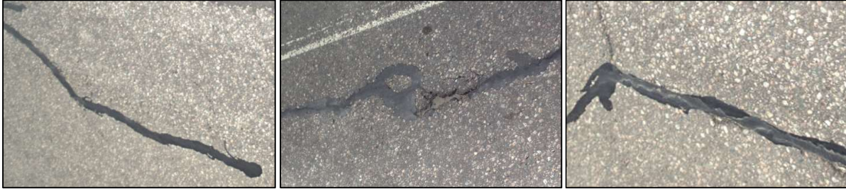
Kuva 15. Edellisessä kuvassa esitettyjen vauriolöytöjen valokuvat. Ensimmäisen kuvan kohdalla vauriota ei ole näkyvissä, todennäköisesti aineistosta havaittu korkeusero aiheuttaa tumman kohteen etäisyysmittausvirheestä. Kahdessa muussa tapauksessa vaurio on nähtävissä myös kuvilla.
