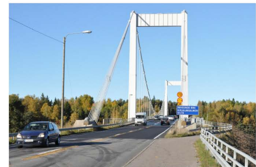
Kuva 3. Nykyinen Kirjalansalmen riippusilta.
