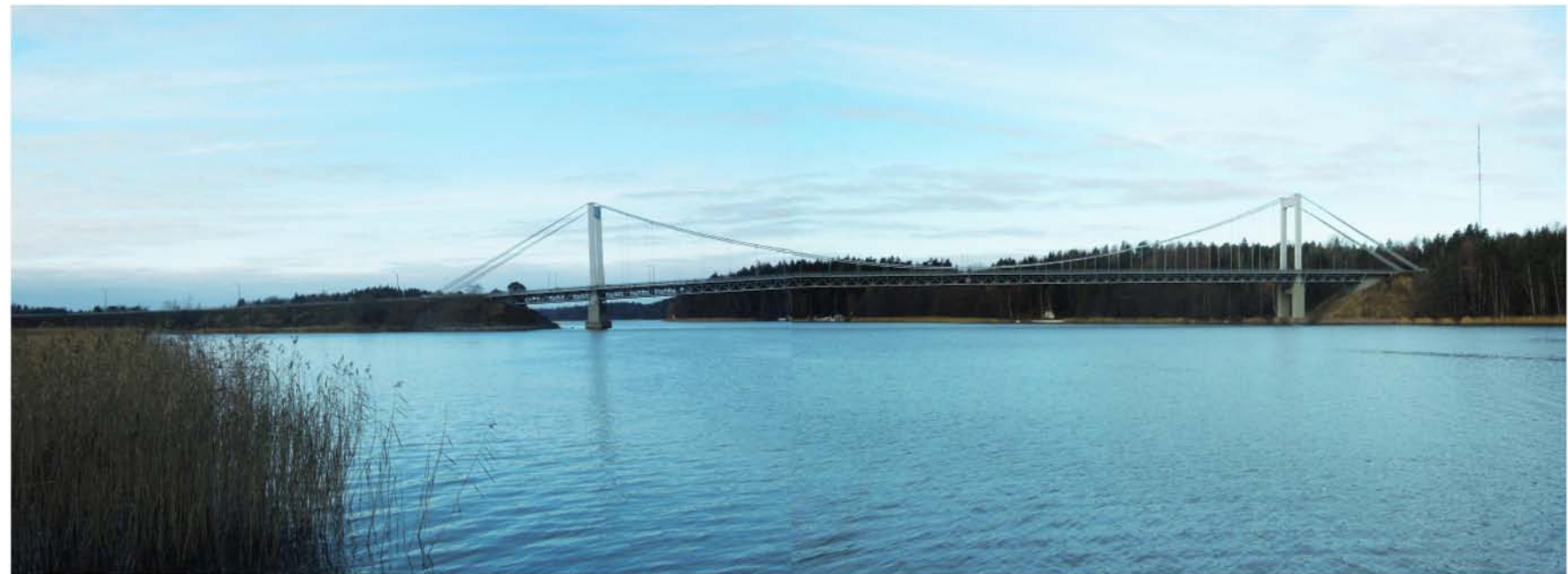
Kuva 10. Nykyinen riippusilta korkeine pyloneineen on näyttävä maamerkki sekä maantiellä että vesitse liikuttaessa.
