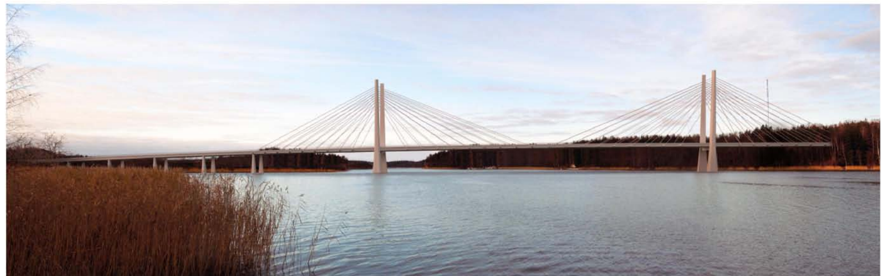
Kuva 30. Havainnekuva kaksipyloisesta sillasta.
