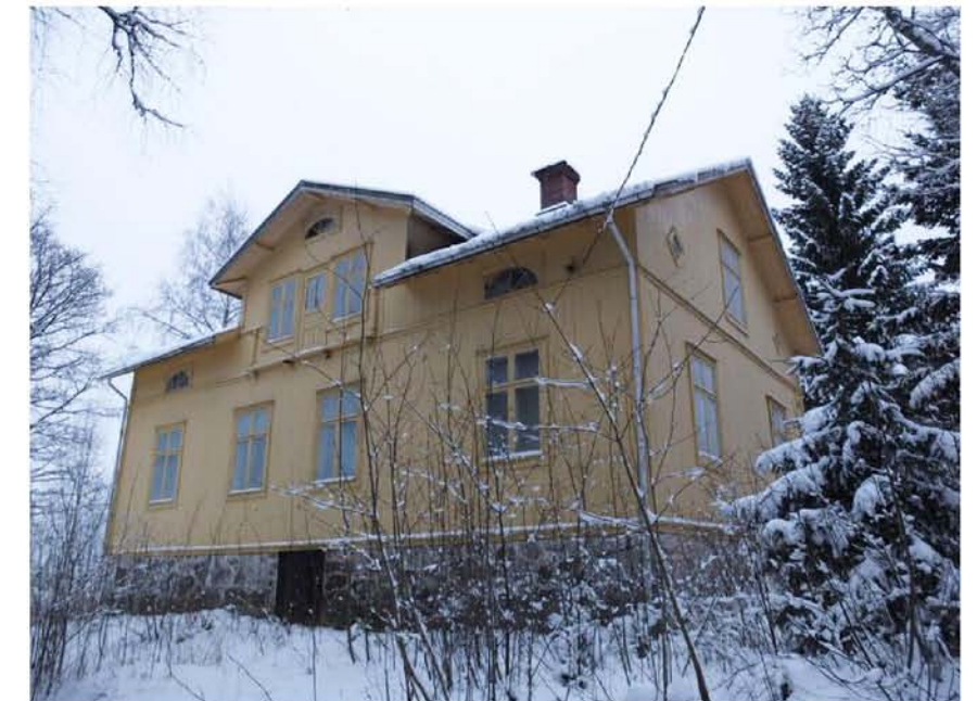
Kuva 13. Fridhemin vanha asuinrakennus.
