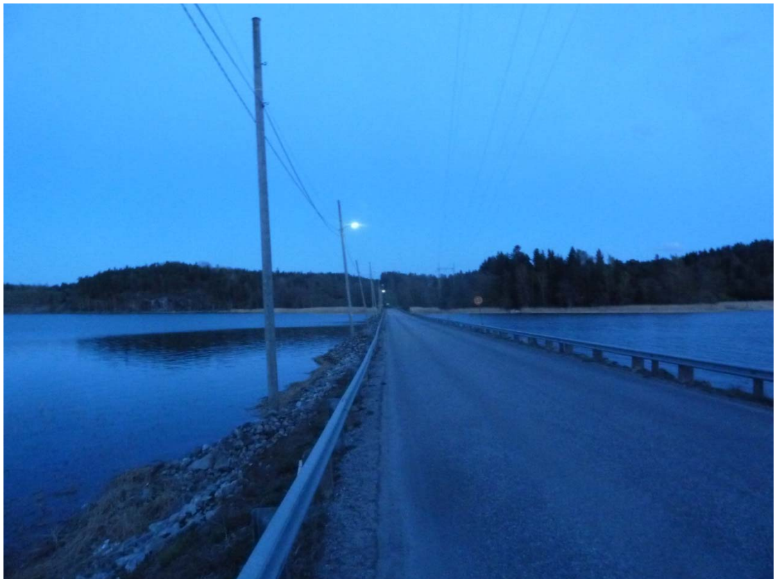
Bild 8. Del av Tervsundsvägen som anlagts på en bank söder om Lillholmen.
