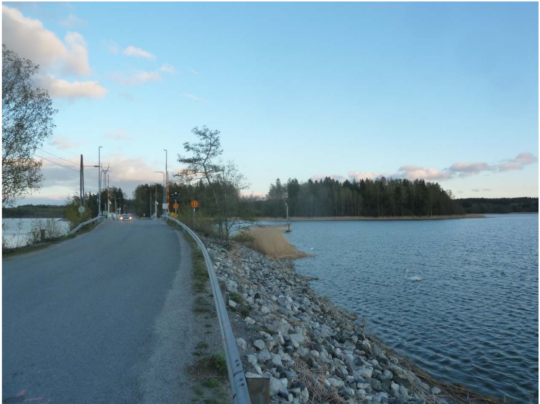
Bild 9. Del av Tervsundsvägen som anlagts på en bank norr om Lillholmen.
