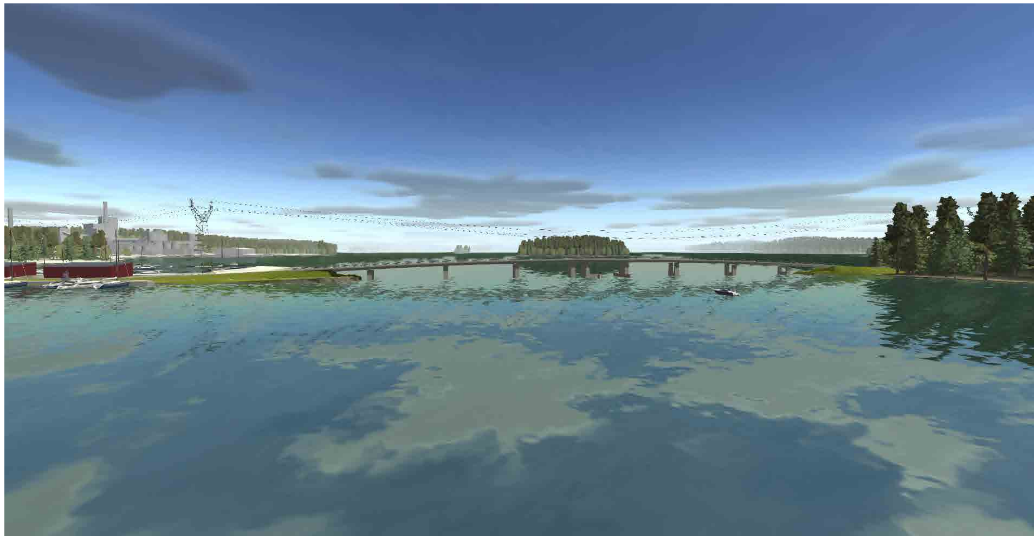
Bild 20. Lillholms bro ovanifrån, sedd från väster. Utjämningen av Skräbbölevägen på vägen som anlagts på den norra banken börjar stiga från lagerbyggnaden som ligger längst i söder mot bron.
