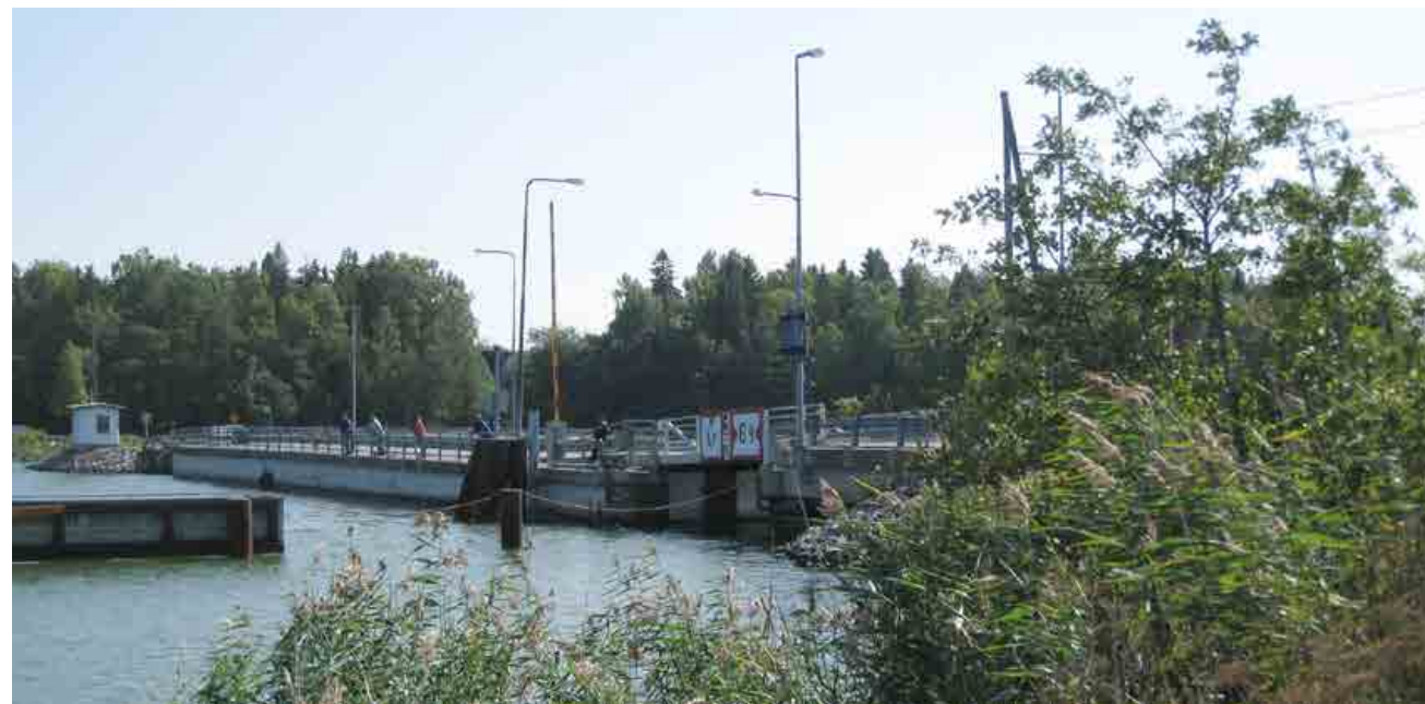
Bild 3. Lillholmens bro ligger i den norra delen av vägbanken. Bild: Anni Räsänen, Pargas stad.
