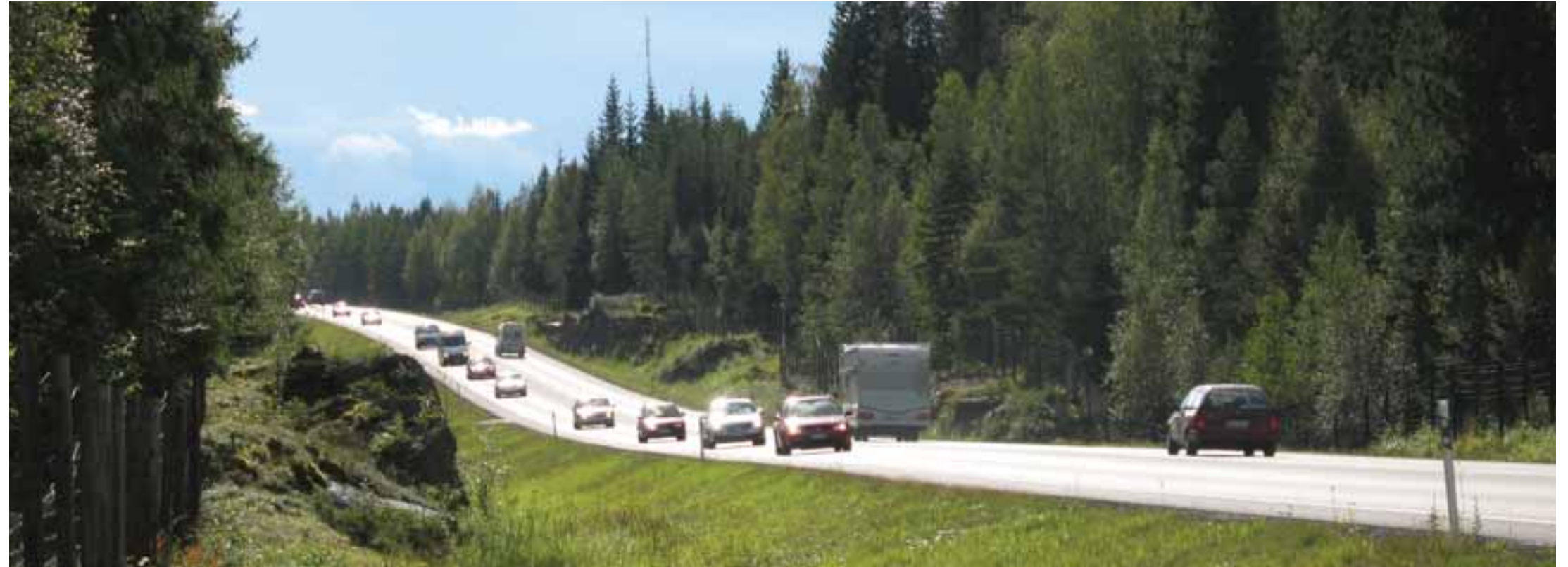
Kuva 24. Tienäkymä Koskuejärven kohdalta.
