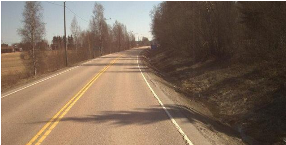
Kuva 2. Suunnitteluosuuden kapein tieosuus sijaitsee Jämsän länsipuolella (Tiekuva: 9/220/950)
