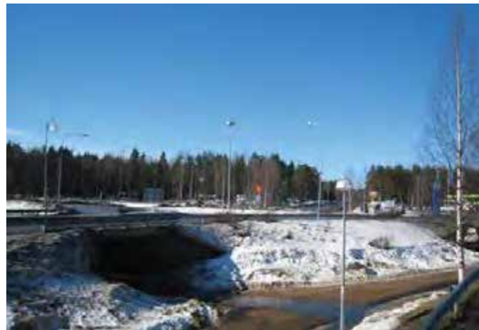
Kiertoliittymä Kaustisella on varustettu kevyen liikenteen alikuluilla.
