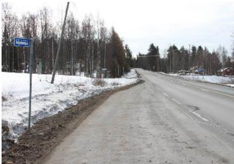
Kuva 7. Valtatien 13 linja-autopysäkeillä ei ole katoksia, korotettua odotustilaa tai muita varusteluja.
