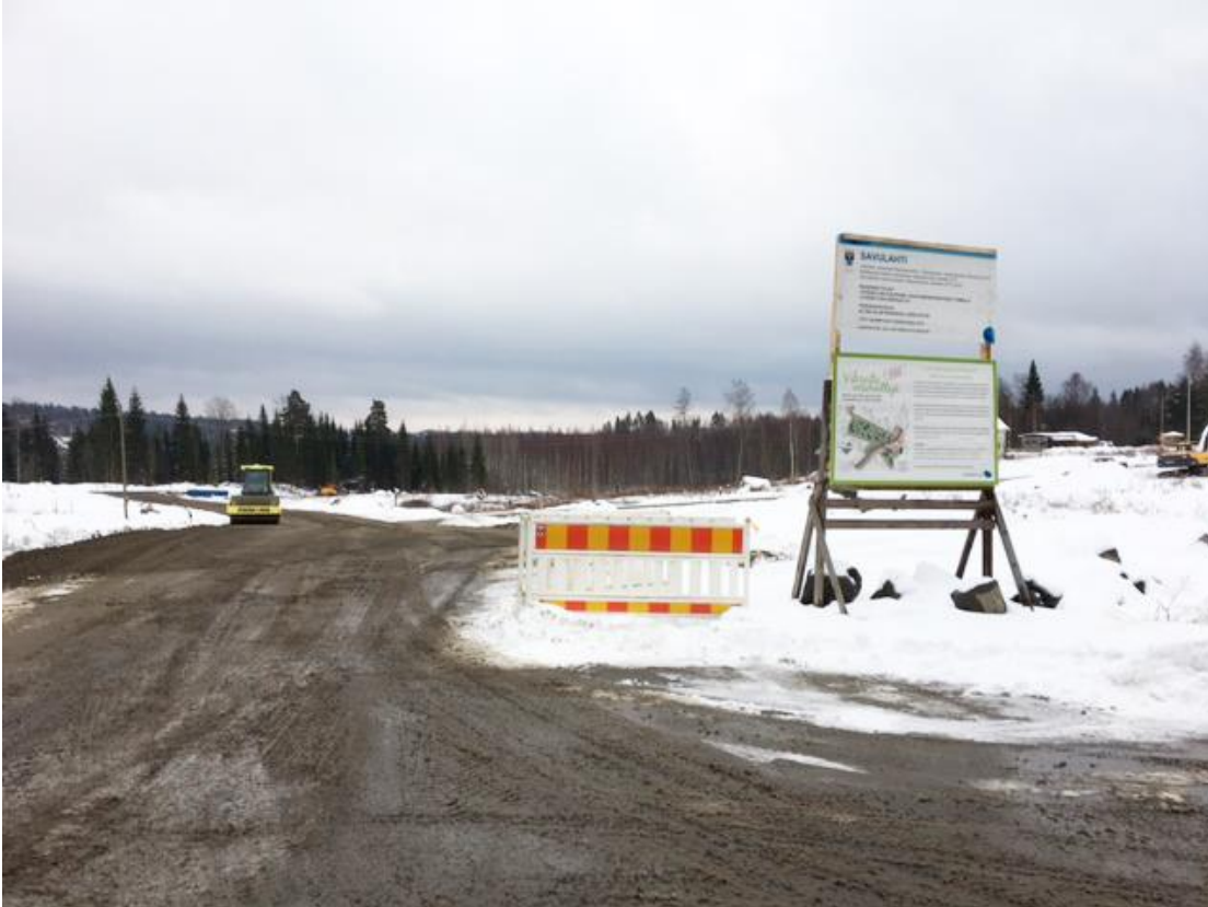
Kuva 14. Savulahti I -alueen rakentaminen on parhaillaan käynnissä.
