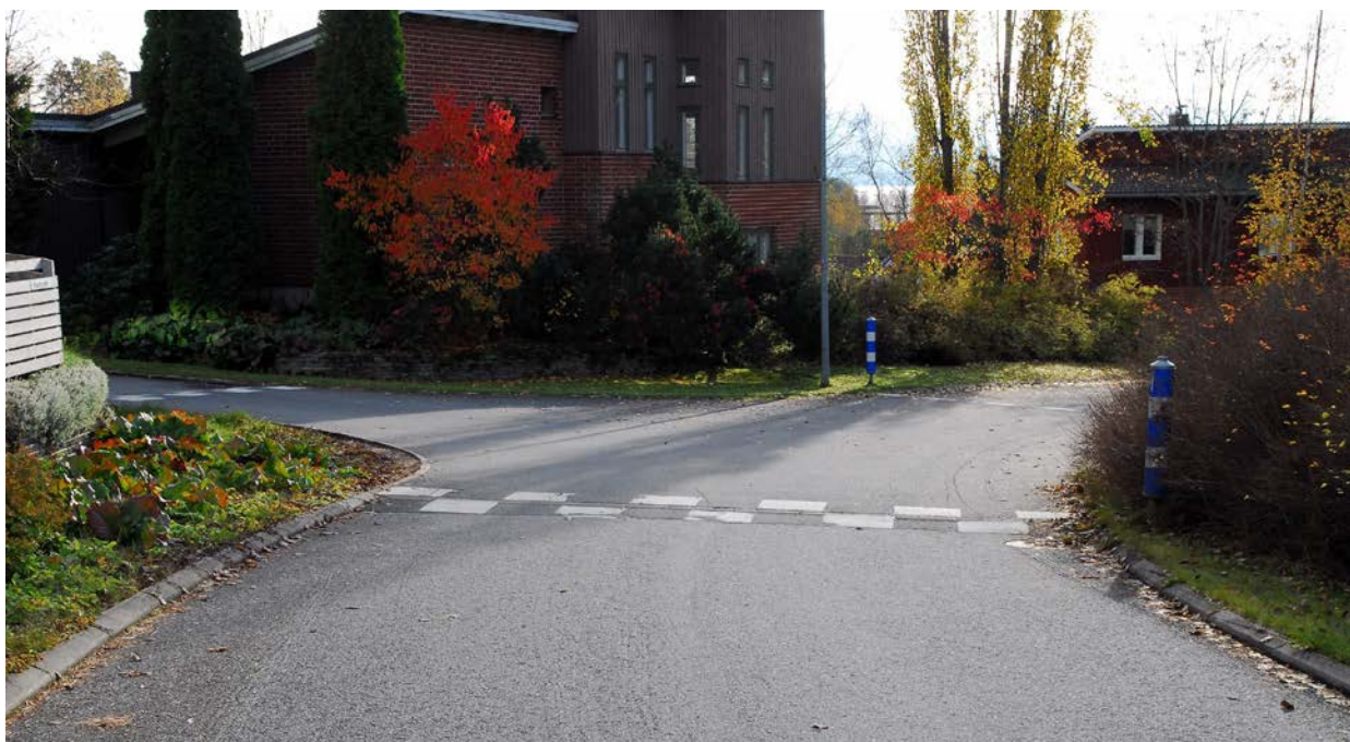
Kuva 30. Korotettu liittymäalue hidastaa jokaisen saapumissuunnan liikennettä, Jyväskylä. (TV)
