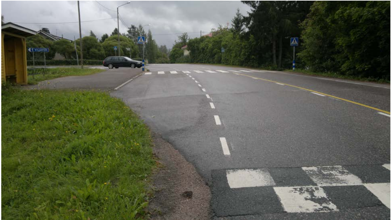
Kuva 13. Korotettu alue kattaa liittymän ja linja-autopysäkin, Pennalantie (yhdystie 11845) Orimattilassa. (OH)
