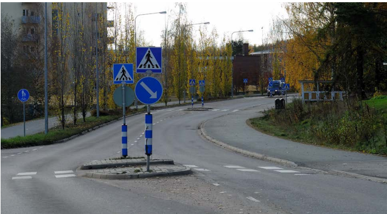
Kuva 1. Suojatiesaareke on yleinen rauhoittamistoimenpide, joka parantaa jalankulkijoiden ja pyöräilijöiden turvallisuutta vaiheistamalla ajoradan ylityksen ja alentamalla vähän moottoriajoneuvojen nopeutta suojatien kohdalla. (TV).
