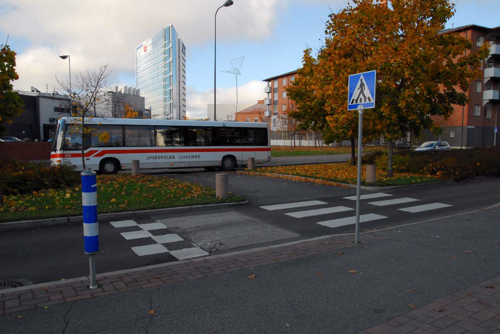
Kuva 14. Tyynyhidasteen vaikutus on suurempi henkilöautoille kuin linja-autoille, Jyväskylä. (TV)
