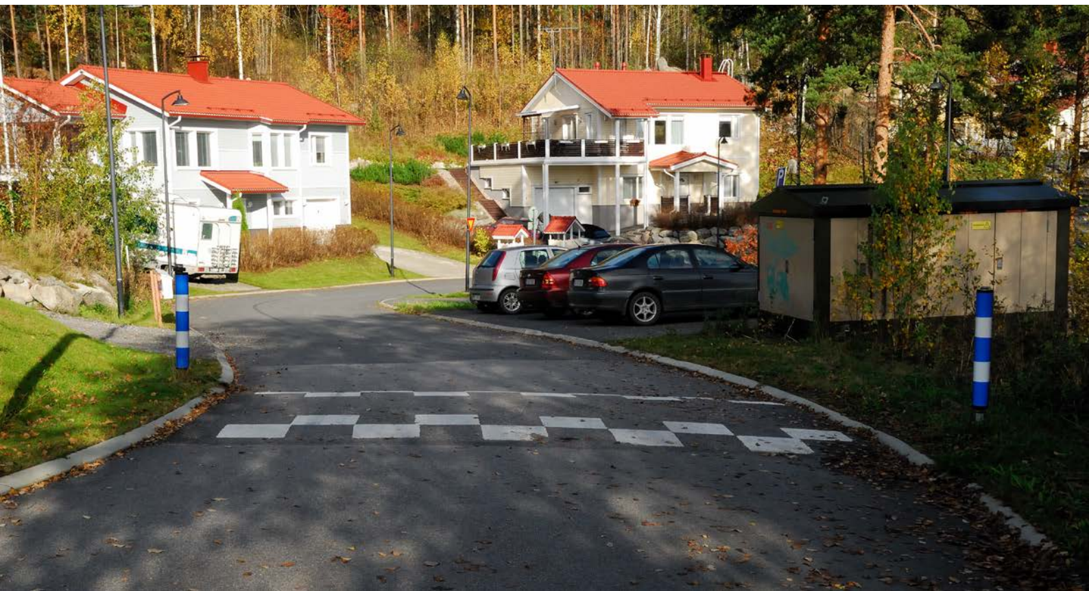
Kuva 29. Ajoradan korotus reunapaaluineen hidastaa ajonopeuksia tehokkaasti, tonttikatu Jyväskylässä. (TV)
