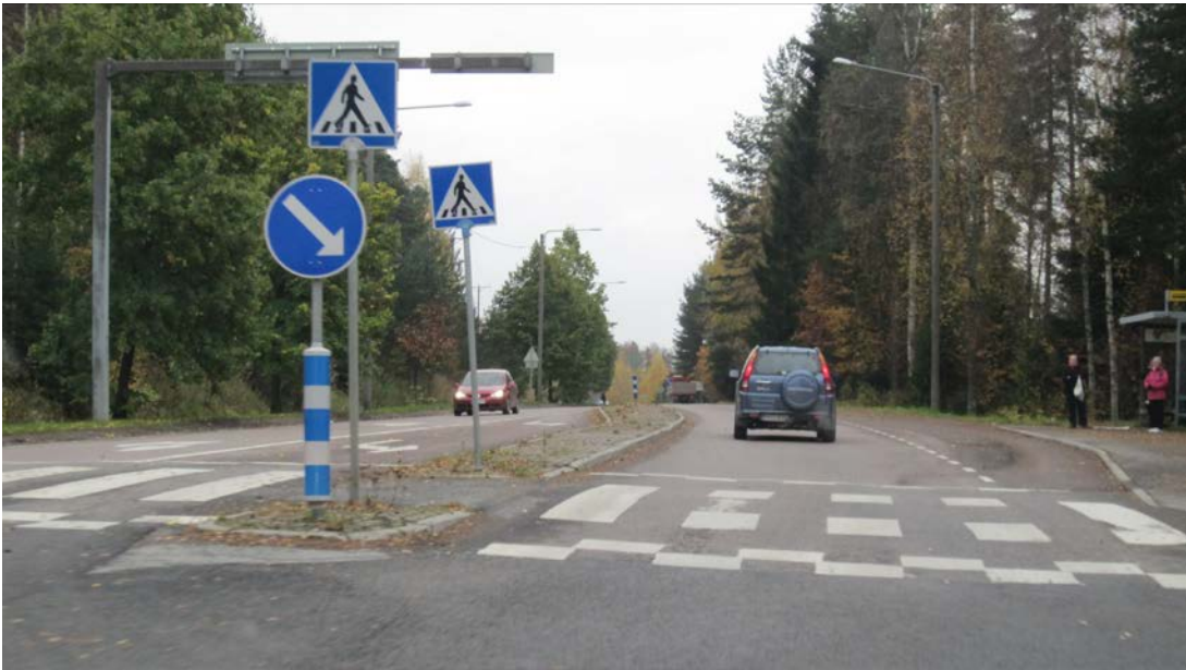
Kuva 11. Jyväskylän Palokassa yhdystiellä 16711 on käytetty loivapiirteisiä suojatien korotuksia. Loiva töyssy ei aiheuta niin suurta iskua ajoneuvoon kuin suoraviisteinen. (AMP)
