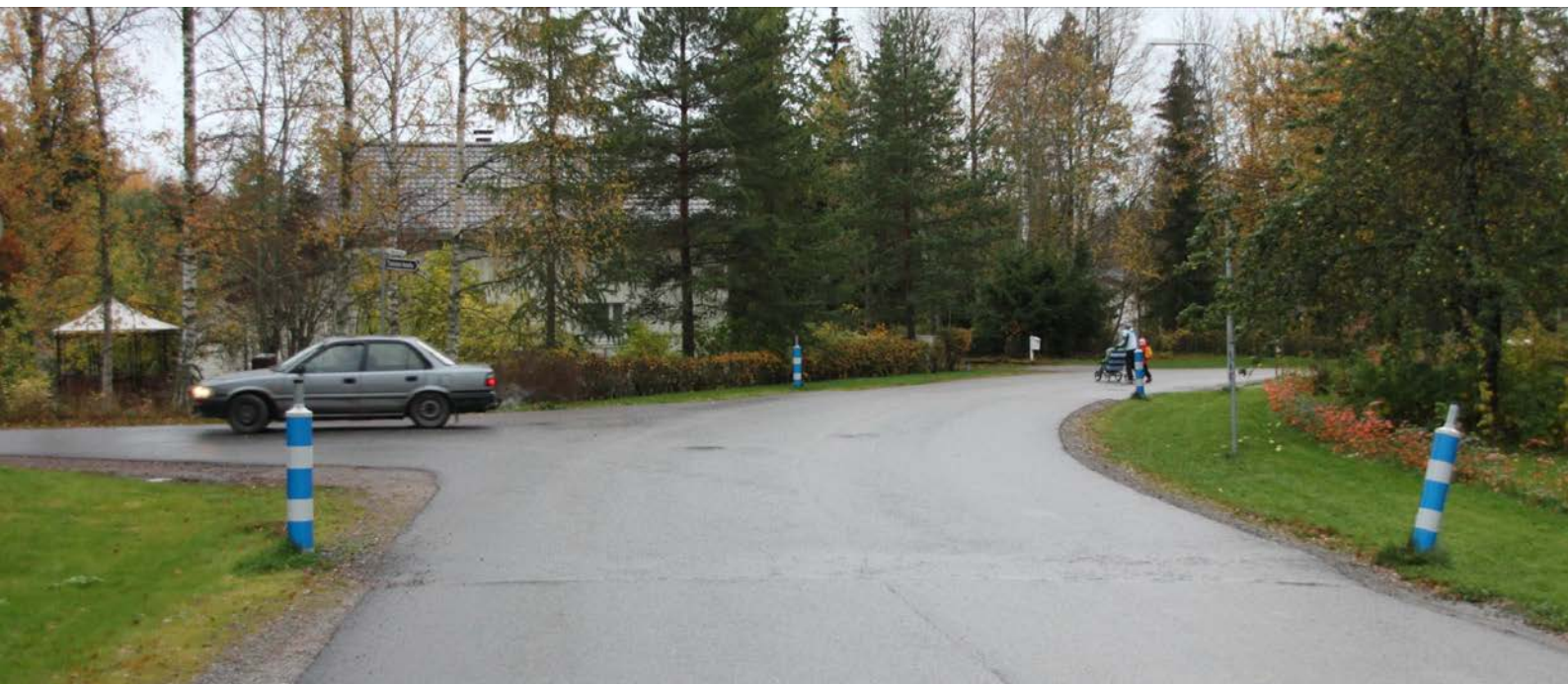
Kuva 25. Korotettua liittymää rajaavat reunapaalut saavat kadun tuntumaan kapeammalta. Pirkkala (JV)
