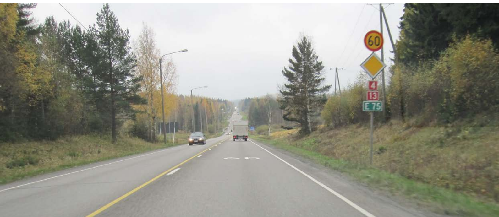
Kuva 26. Nopeusrajoitus ja ajorataan maalattu nopeusrajoitus toimivat yhdessä tehokkaammin kuin pelkkä nopeusrajoitus, valtatie 4 Puuppola. (AMP)
