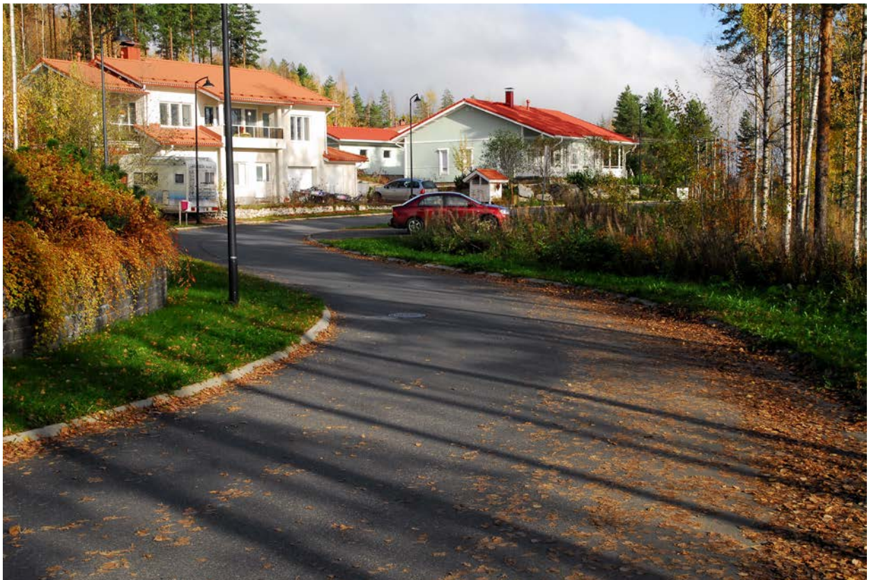
Kuva 2. Kun liikenneympäristö ja väylän linjaus kertovat hiljaisen ajonopeuden tarpeen, minimoituvat ylinopeudet luontevasti, eikä tarvita erillisiä rakenteellisia hidasteita. (TV)
