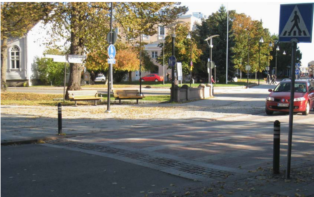
Kuva 12. Suoraviisteisen töyssyn pystyy rakentamaan ladottavista kivistä, Rauma. (JV)
