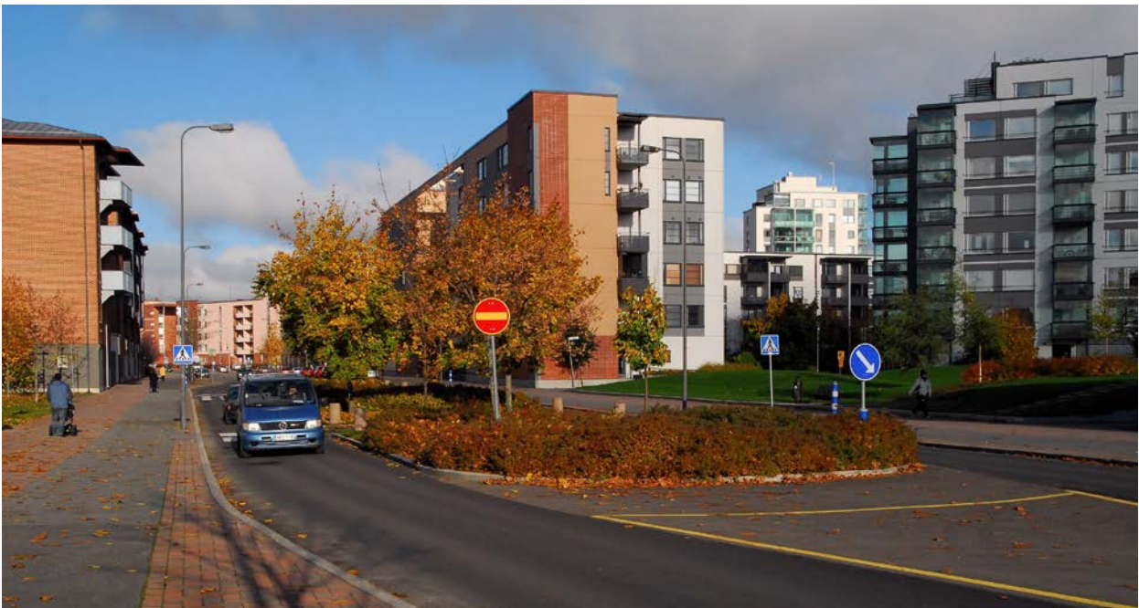
Kuva 17. Leveällä keskisaarekkeella voidaan kaventaa ajorataa ja muodostaa ajoradan sivusiirtymä, Jyväskylä. (TV)
