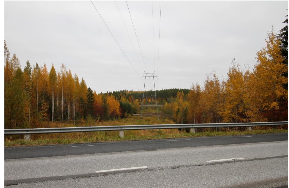
Kuva 12. Näkymä Ruokeentieltä pohjoiseen voimalinjaa pitkin Ruokepuolisen pohjoispuolelta.
