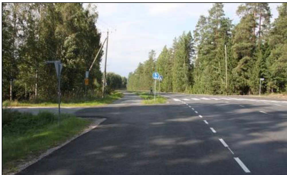
Kuva 4. Kevyen liikenteen väylä Muuntamontien ja Mustaniementien liittymästä Vääksyn keskustaan päin.
