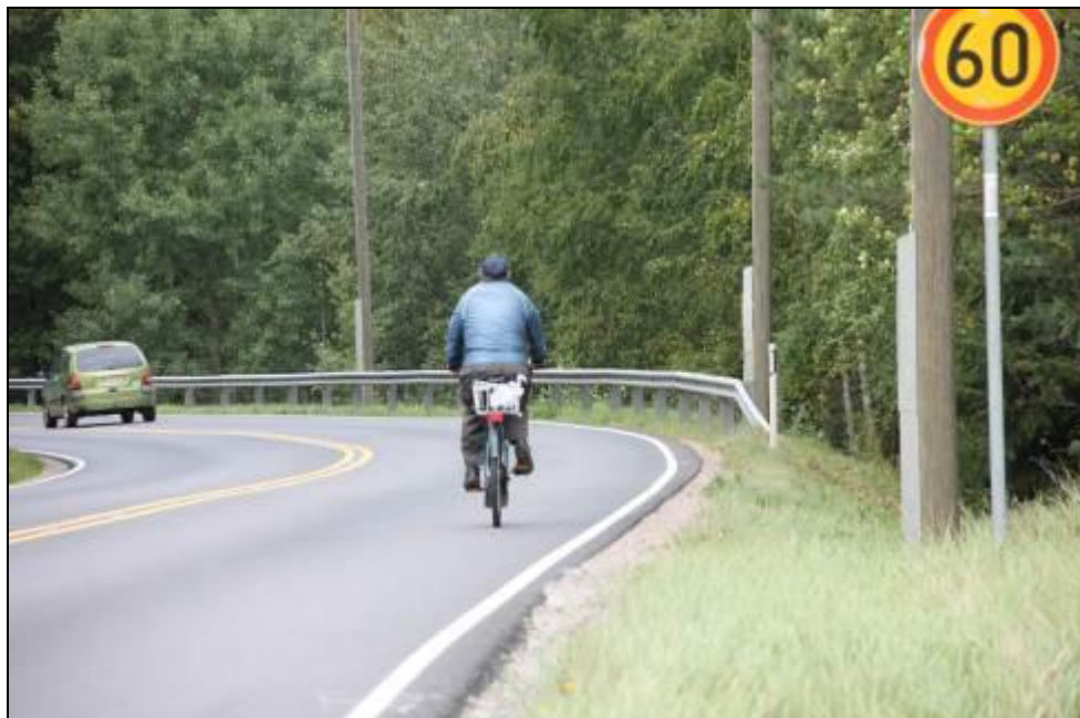
Kuva 8. Tieosat, joilla pientareet ovat kapeat, ovat turvattomia jalankulkijoille ja pyöräilijöille.
