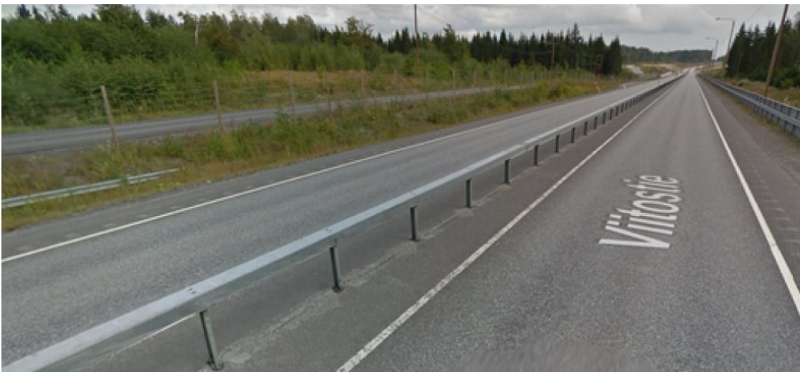
Kaidetila on osa tien keskialuetta. Kaidetilaa on 15 cm kummankin ajoradan puolella.
