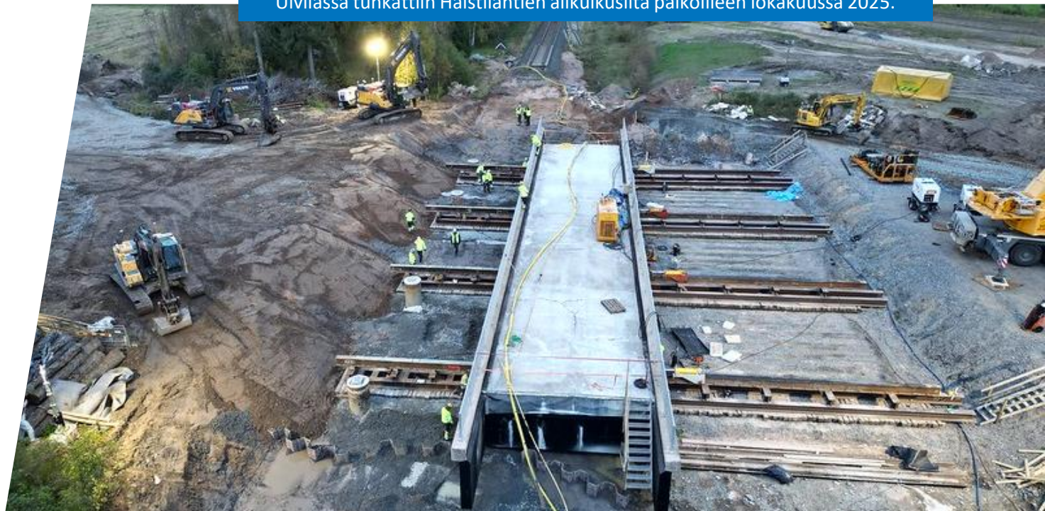
Uvilassa tunkattiin Haistilantien alikulkusilta paikoilleen lokakuussa 2025.
