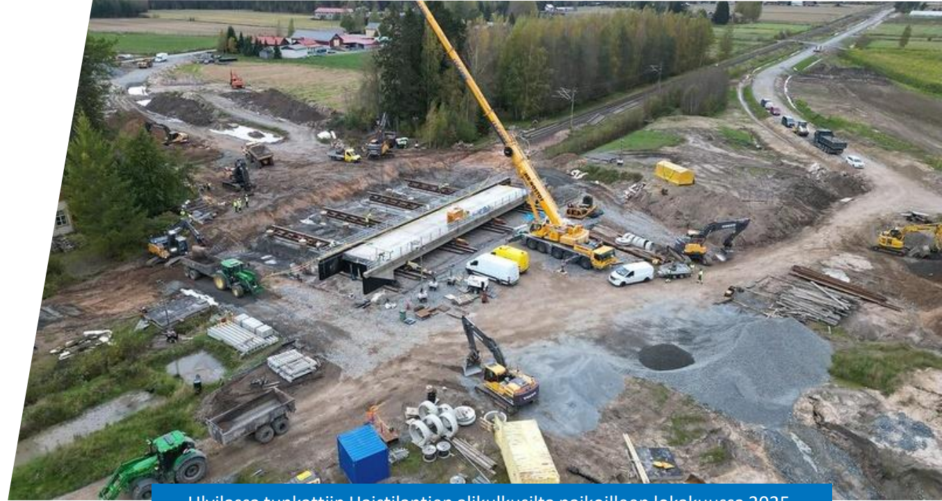
Uvilassa tunkattiin Haistilantien alikulkusilta paikoilleen lokakuussa 2025.
