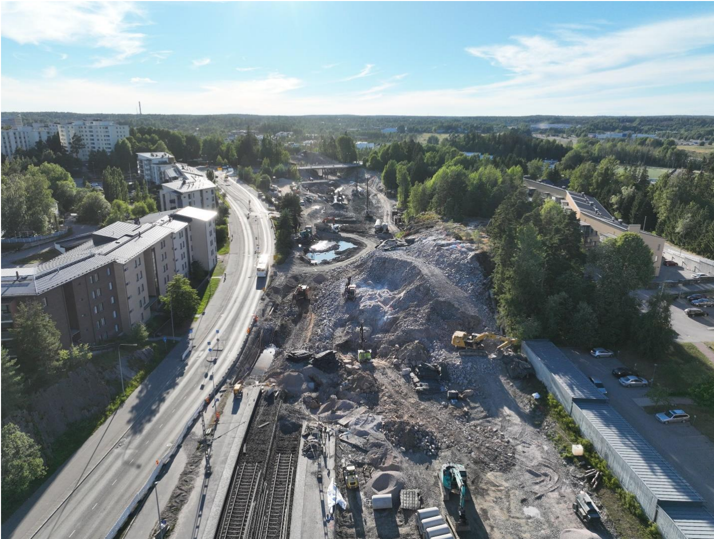
Kallioleikkausta sekä pohjanvahvistustöitä Tuomarilan länsipuolella
