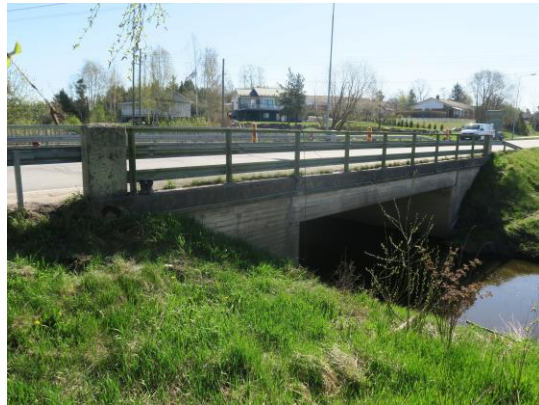
Kostiaisten silta 2021, Trex
