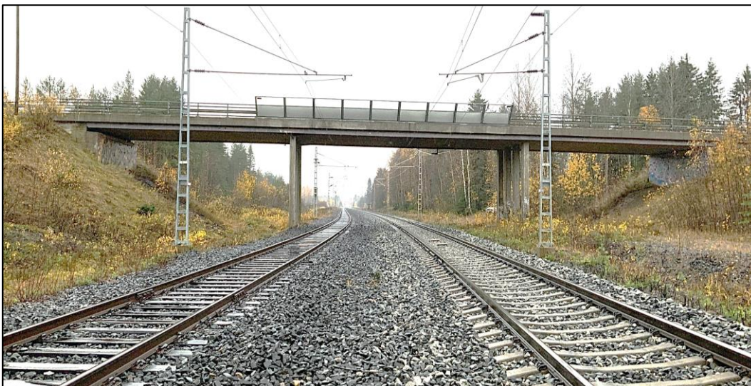
Kuva 4. Näkymä radalta nykyisen ylikulkusillan pohjoispuolelta etelän suuntaan (Haukiputaan liikennepaikka)
