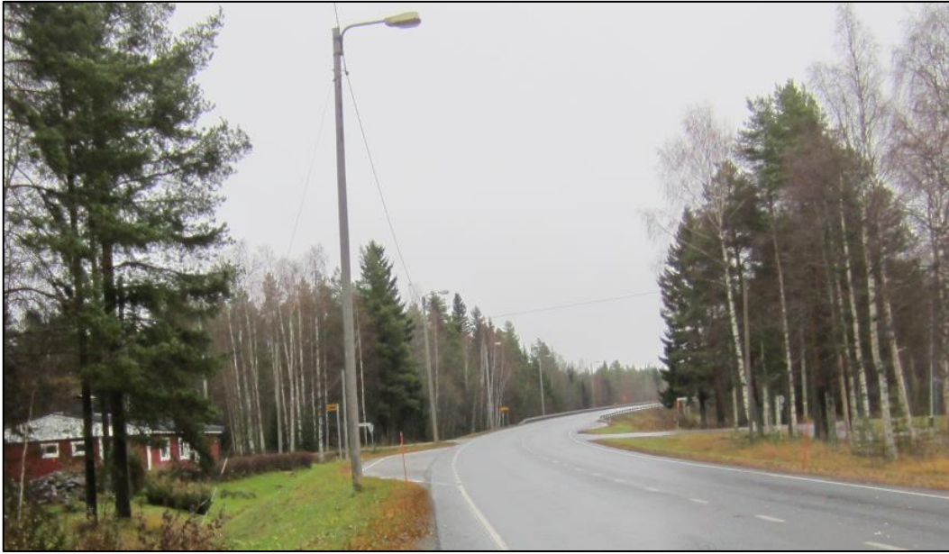
Kuva 3. Näkymä maantieltä 8460 Torvelantien liittymän eteläpuolelta rautatien suuntaan
