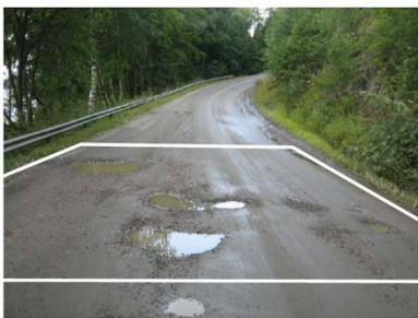
Kuva 4. Tien pinnalla on liikennettä mahdollisesti vaarantava tai ajoneuvon rikkova kohta.
