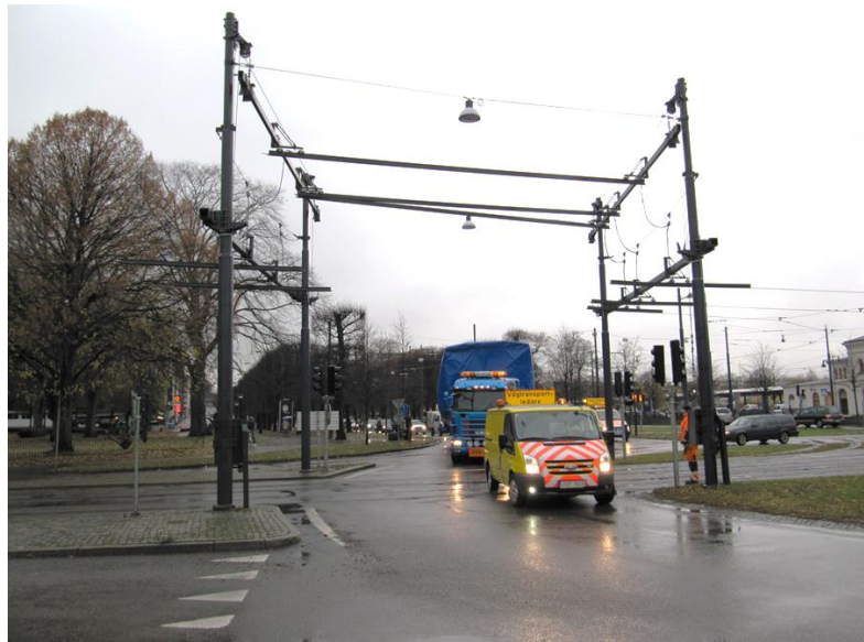
Kuva 21. Norrköpingin nostolaite, ajojohtimet ylös nostettuna. (Kuva: Ratatek)
