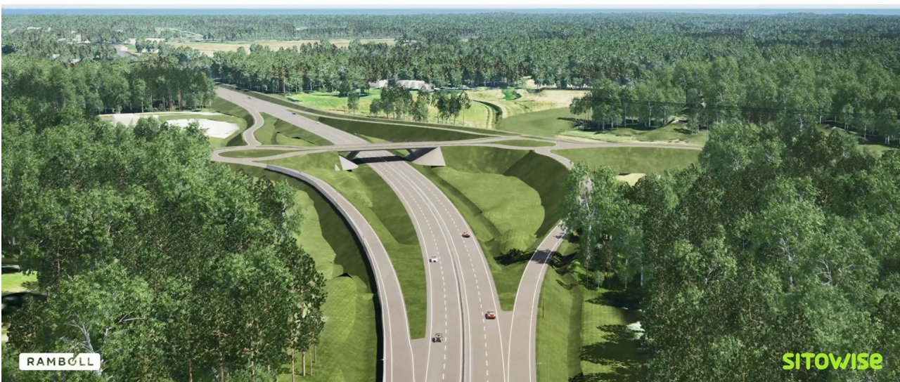
Kuva 63. Olkiluodon eritasoliittymä sijoittuu samalle kohdalle, jossa Pohjanlahden rantatien historiallinen linjaus siirtyy valtatie itäpuolelta länsipuolelle
