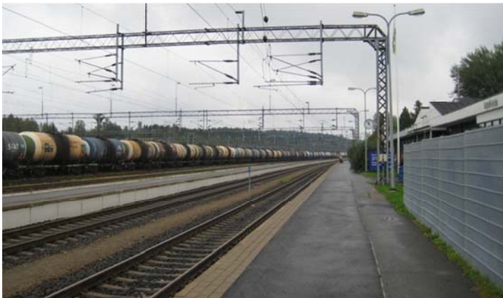
Kuva 17. Reunalaituri ja aita asemarakennuksen länsipuolella, portaiden ja katon sijoitus vaatii aidan siirtämisen. (kuva: Mikko Simola 2011)
