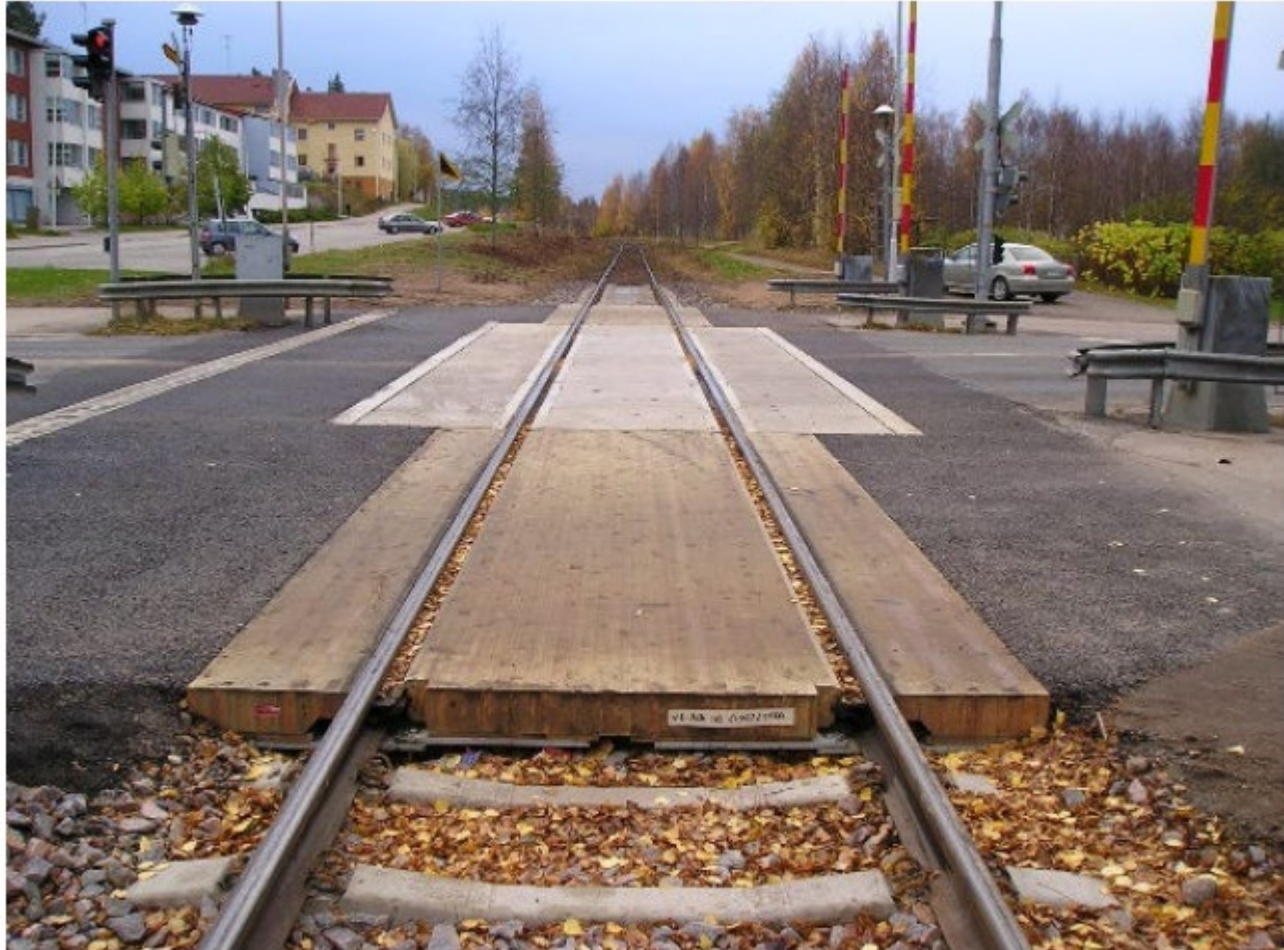
Kuva 30. Puu-betoni-yhdistelmä rakenne raiteen suunnassa
