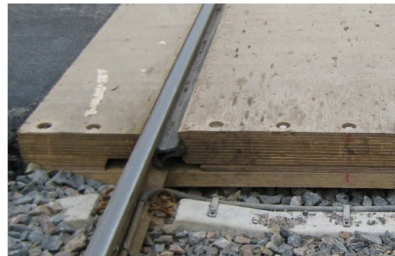
Kuva 4. Tasoristeyksen puisen kansirakenteen ankkurointi
