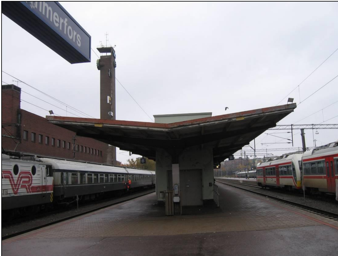
Ensimmäisen välilaiturin katoksen pääty
