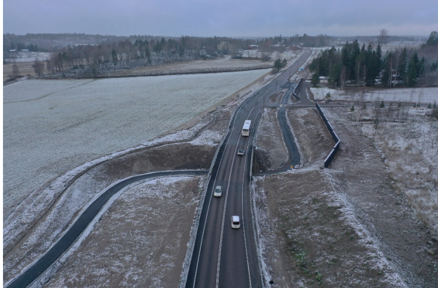
Kuva 1. Numlahden alikulkukäytä (S104) ja Mt132 alittava kevyen liikenteen väylä, kuva 20.11.2020
