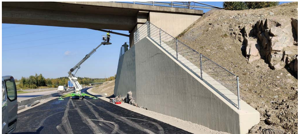
Kuva 2. S6 hulevesi kourujen asennus ja tukimuurin kaiteet asennettu, kuva 23.9.2020
