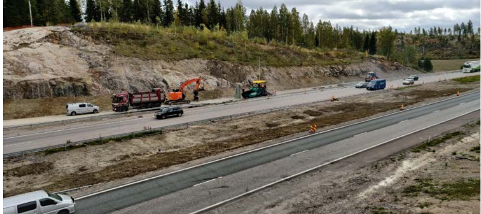
Kuva 3. Rampin E5R1 alimman päällystekerroksen levittäminen, kuva 22.9.2020
