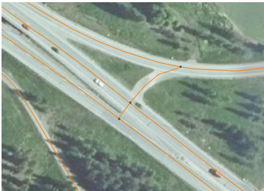
Kuva 44. Ilmakuvalta erottuva erikoiskuljetusyhteys huoltoaukolta rampille.
