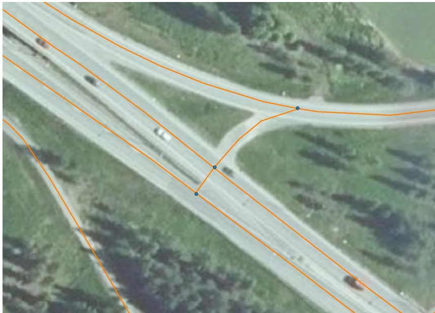
Kuva 47. Ilmakuvalta erottuva erikoiskuljetusyhteys huoltoaukolta rampille.
