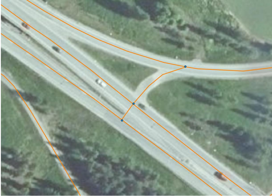
Kuva 44. Ilmakuvalta erottuva erikoiskuljetusyhteys huoltoaukolta rampille.
