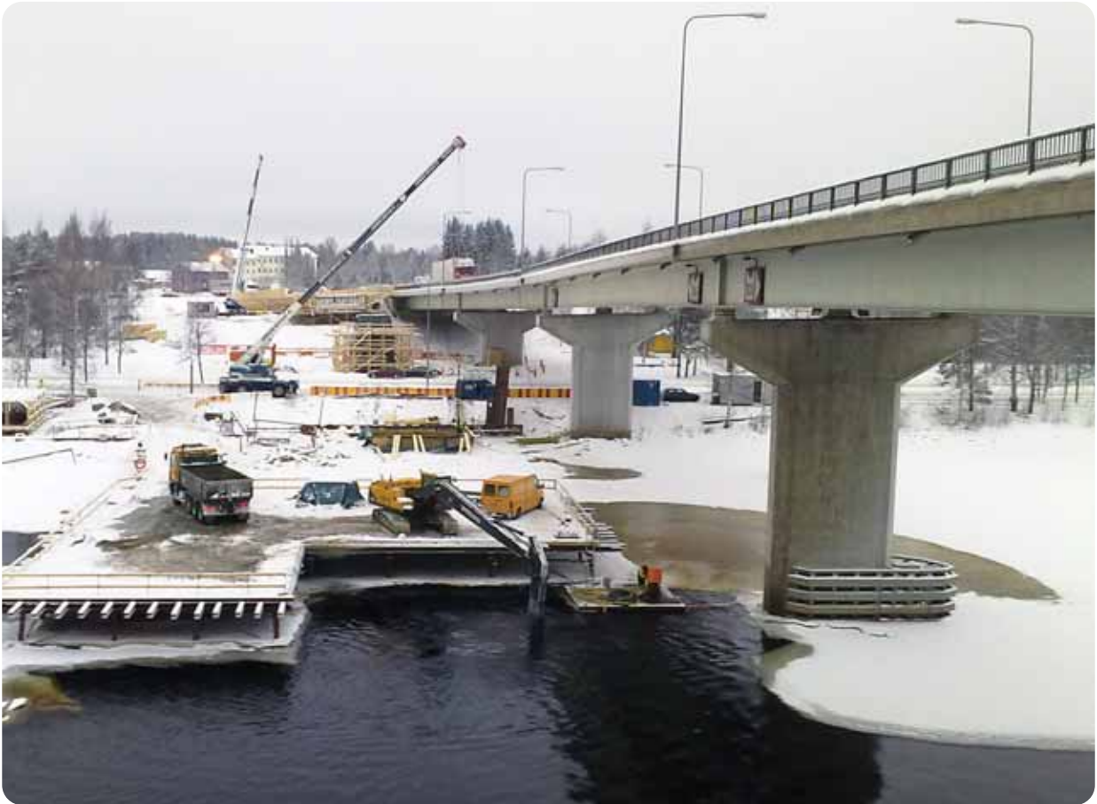
Osa välitukien perustuksista tehtiin työlaualta. Kuva joulukuulta 2010.
