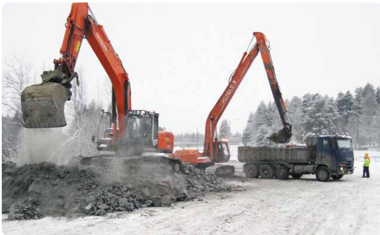
Kehätietyömaa on tarjonnut töitä noin 200 alihankkijalle pääosin Joensuun seudulta.
