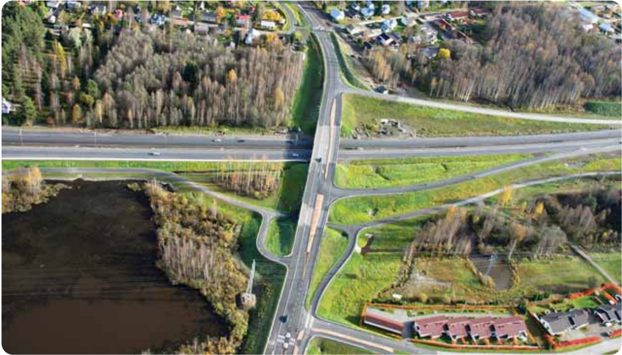
Aikaisemman Karjalankadun liikennevaloristeyksen tilalle on rakennettu uusi eritasoliittymä. Karjalankatu on johdettu kehätien ylitse. Liittymässä on suorat rampit vain etelään. Tämän vuoksi Niinivaaran ja kehätien pohjoissuunnan välinen liikenne on ohjattu Kettuvaarantien liittymään. Kehätien suuntainen uusi kevyen liikenteen väylä kulkee Karjalankadun alitse. Karjalankadun kevyen liikenteen väylä on kadun pohjoisreunassa. Kuva länsisuunnasta.
