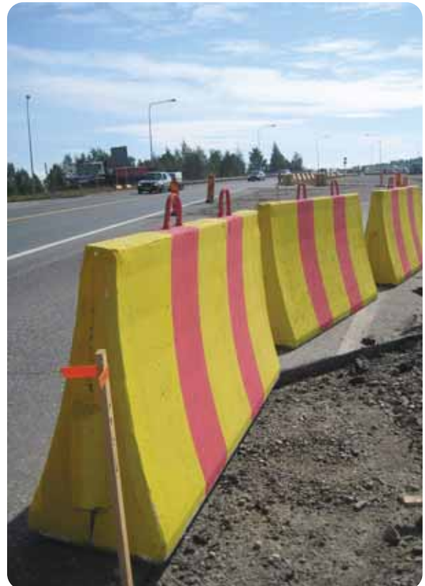
Siirrettäviä betoniporsaita käytettiin runsaasti työnaikaisissa liikennejärjestelyissä.
