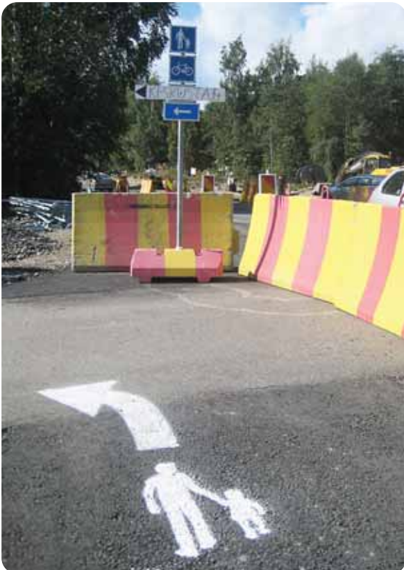
Kevyen liikenteen väliaikaisjärjestelyä Karjalankadulla kesällä 2011.
