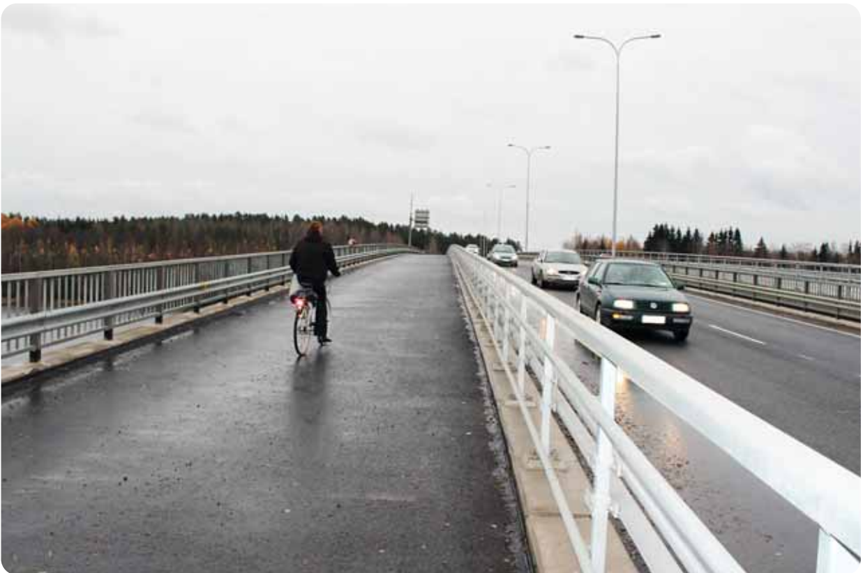
Vanhalle Pekkalan sillalle on lisätty kevyen liikenteen väylän suojakaide.
