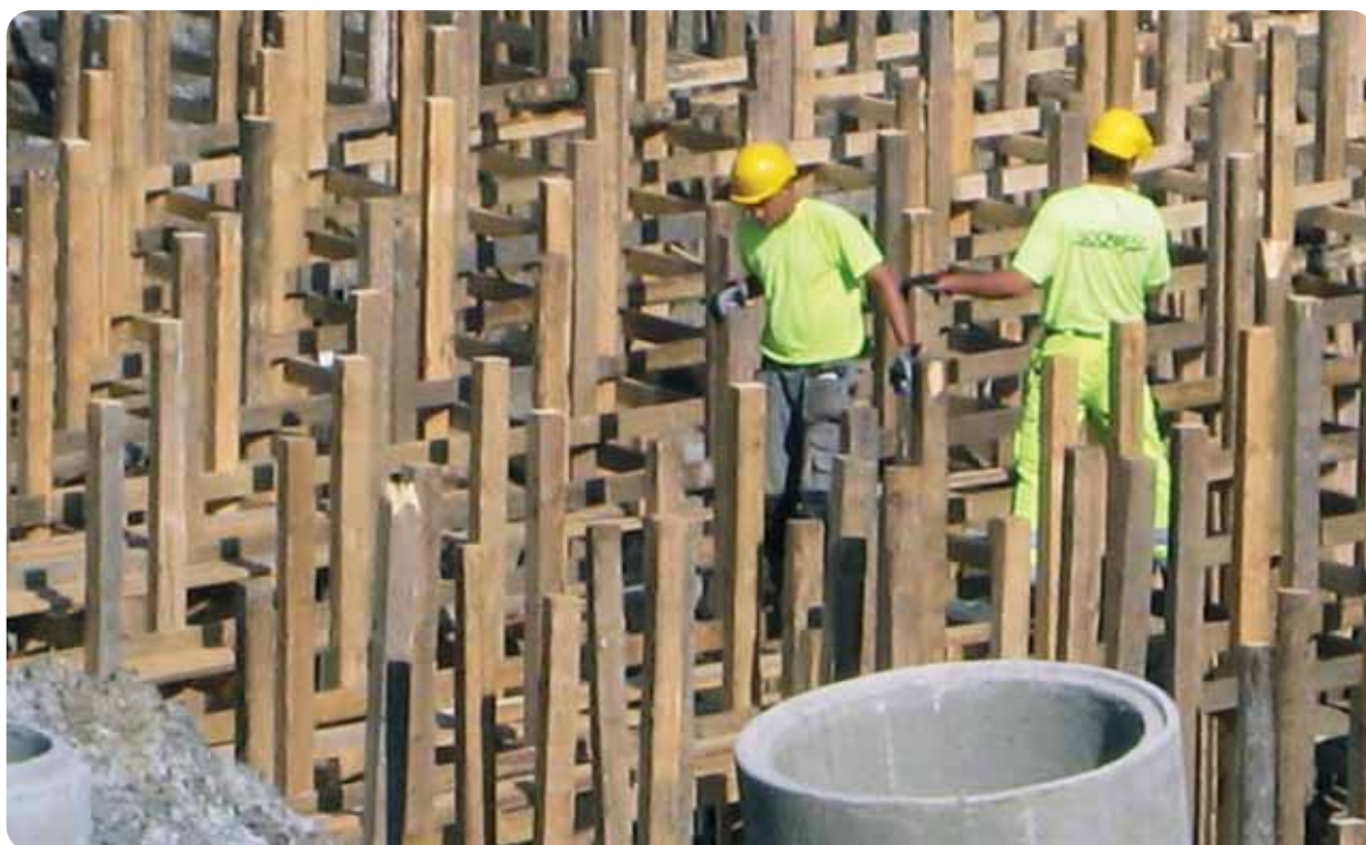
Kettuvaarantien siltatyömaa elokuussa 2011
