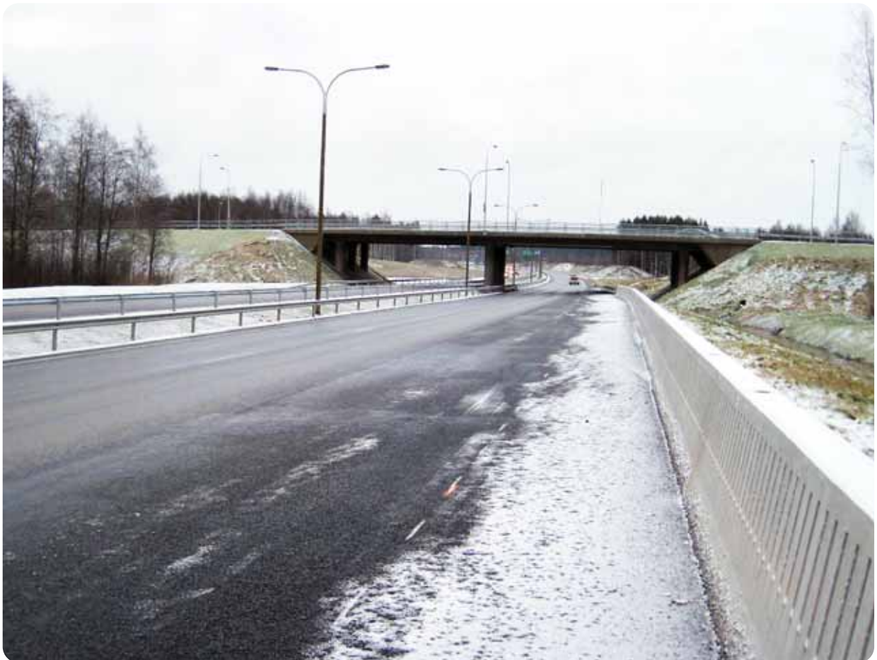
Ajoratamaalauksia vaille valmista tietä marraskuussa 2012. Karjalankadun silta pohjoisesta. Melukaide suojaa Varaslammen aluetta.
