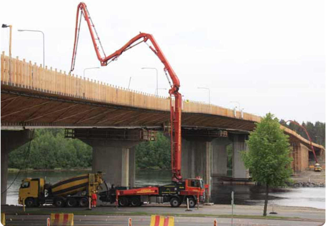
Sillan kannen valu kesäkuussa 2011 kesti kaksi vuorokautta. Betonia käytettiin 2000 m 3 .
