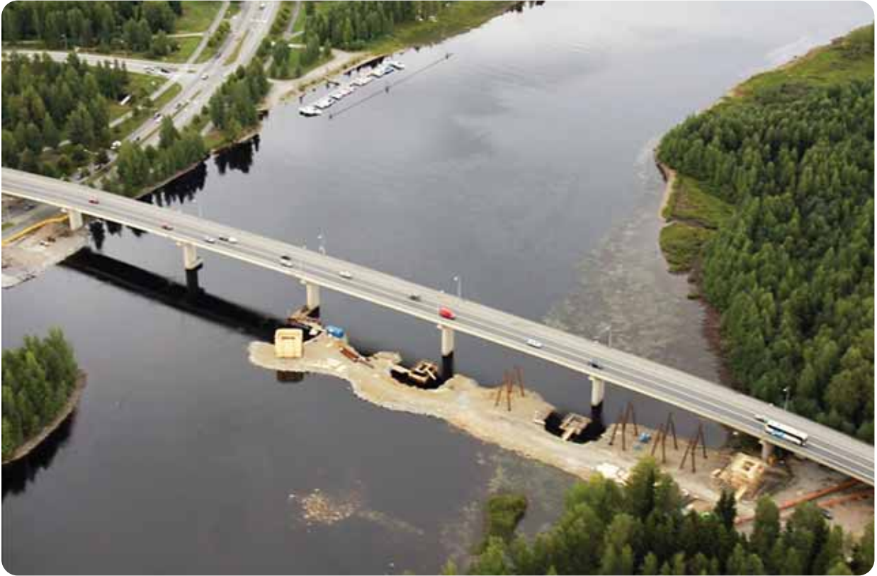
Vesistöpenger ja välitukien perustusten muotteja kesällä 2010
