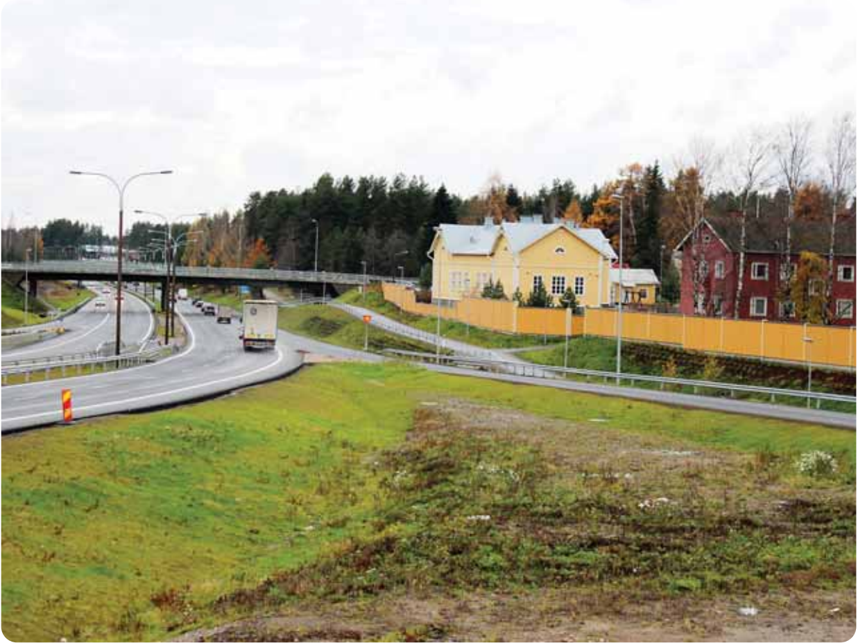
Mutalan (kuvassa) ja Siihtalan asutuksen suojaksi rakennettiin meluaitoja. Meluaidat ja niiden värit herättivät alueella runsaasti keskustelua.
