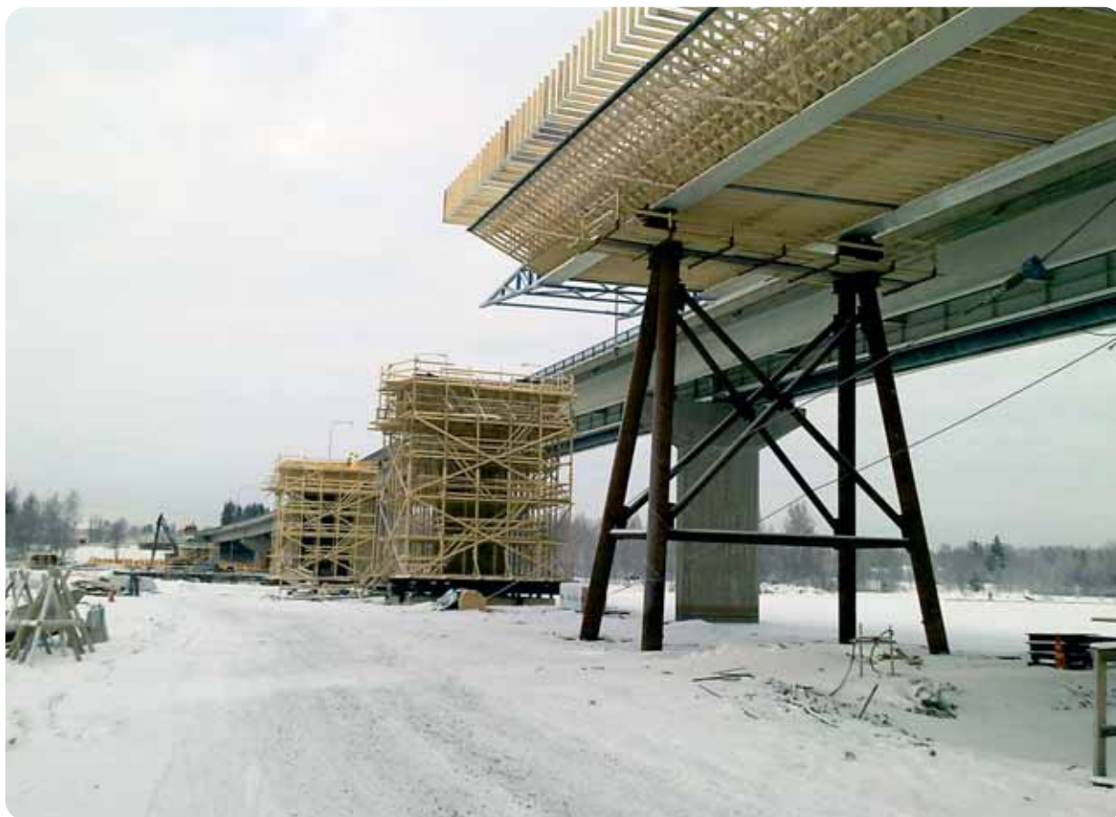
Sillan kansirakenteita asennetaan paikoilleen joulukuussa 2010.
