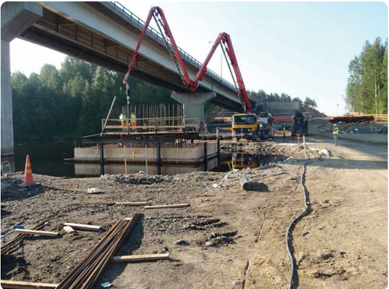
Välituen kasuuniperustuksen valu kesällä 2010
