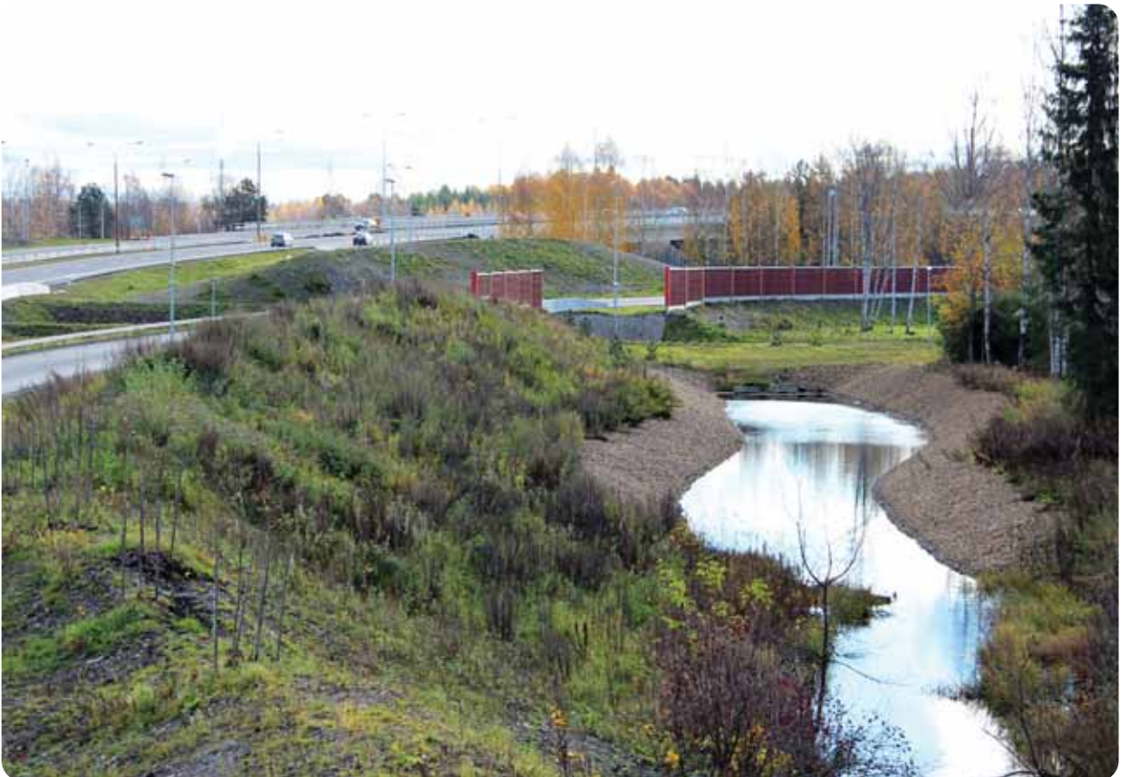
Purunuomia on muotoiltu uudelleen. Kuvassa Siihtalan asuintalojen suojaksi rakennettua meluseinää.
