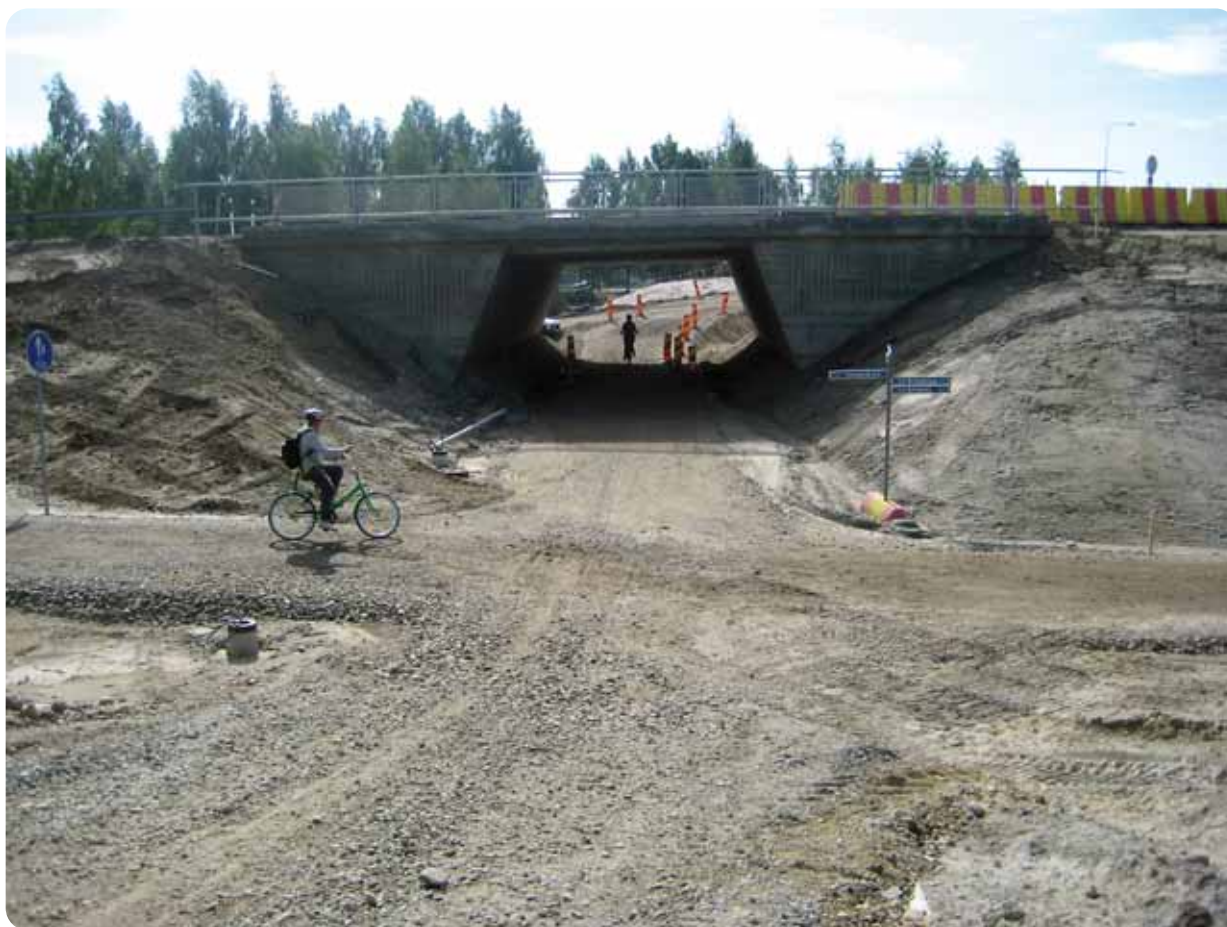
Työmaan aikaisiin kevyen liikenteen järjestelyihin on kiinnitetty erityistä huomiota, mutta kokonaan haitoilta ei ole voitu välttyä. Kuvassa Lastenkadun alikulkukäytävä Siihtalassa elokuussa 2011.
