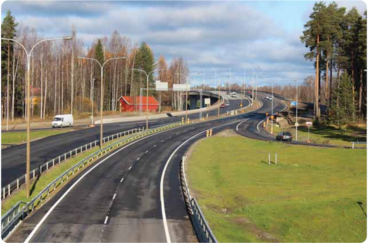
Kehätien keskisaralla on käytetty puisia valaisinpylväitä, mutta silloilla, rampeilla ja kevyen liikenteen väylillä on metalliset valaisinpylväät. Rengasmelua vaimennetaan matalilla betonikaiteilla. Kuva Kettuvaarantien risteysillalta pohjoiseen.
