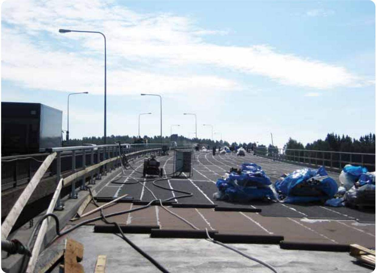
Sillan kannen eristystyöt elokuussa 2011.
