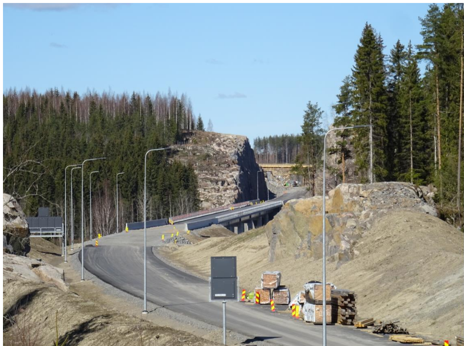
Kuva 2. Luhdanjoen silta, taustalla Patiokallion risteysilta
