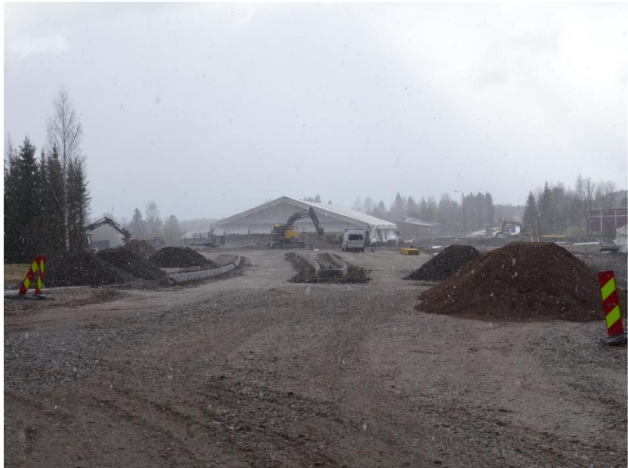
Kuva 4. Nikulan risteyssillan sääsuoja ja Helsingintien kiveystöitä. Töitä tehtiin keväisen vaihtelevissa olosuhteissa.
