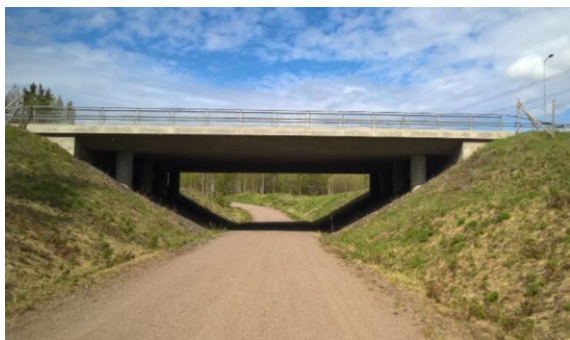
Kuva 9. Yllikkälän ja Hurtanmaan yksityisteiden kohdille rakennetut risteyssillat / riista-alikulut.
