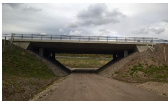
Kuva 9. Yllikkälän ja Hurtanmaan yksityisteiden kohdille rakennetut risteyssillat / riista-alikulut.
