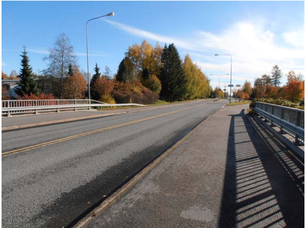
Kuva 8. Valtatie etelästä kohti pohjoista Alkiontien risteyssillan kohdalta
